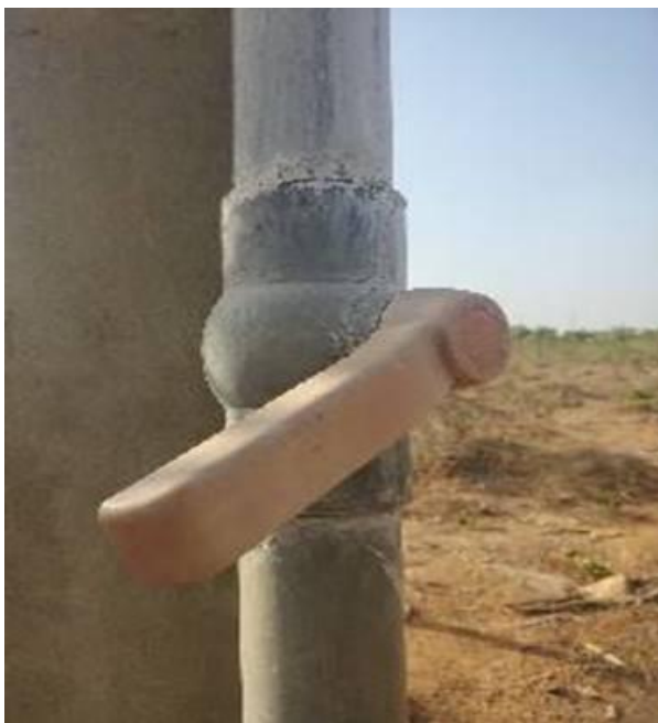
Photo 5 : Tuyau de refoulement de l'eau du réservoir
