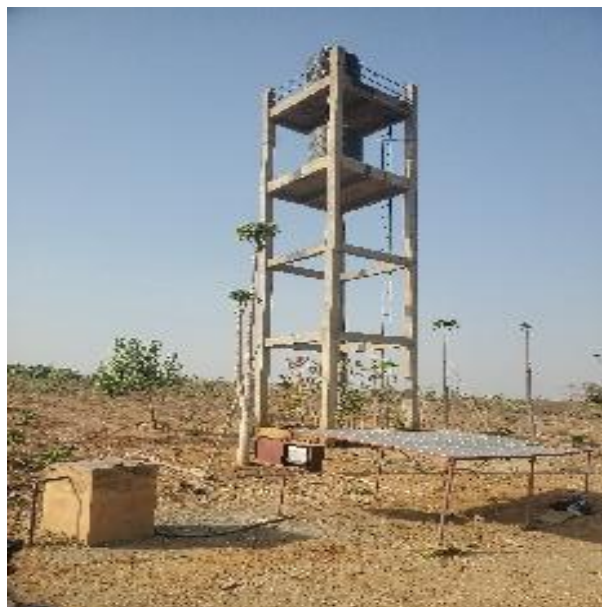
Photo 1 : Tête du forage et du réservoir surélevé
