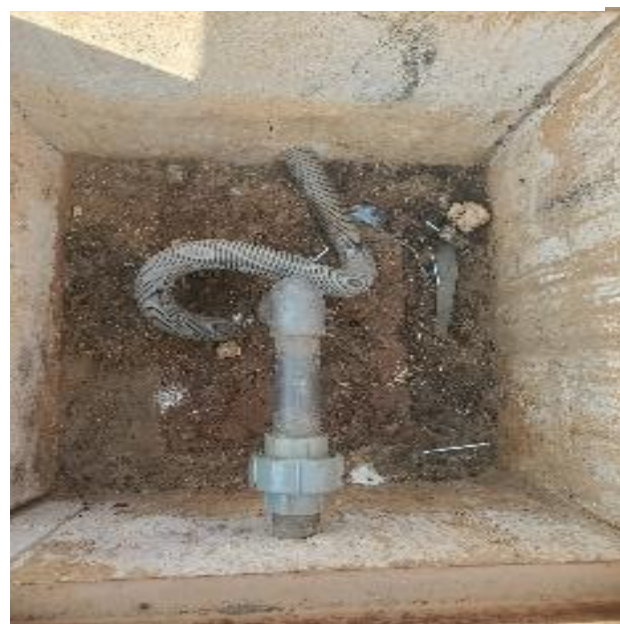
Photo 3 : Vue de dessus de la tête de forage
