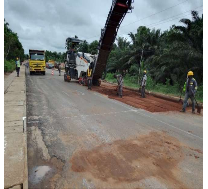
Figure 3- 10 exécution des travaux de décaissement
