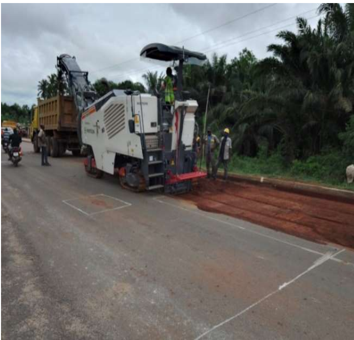
Figure 3- 10 exécution des travaux de décaissement
