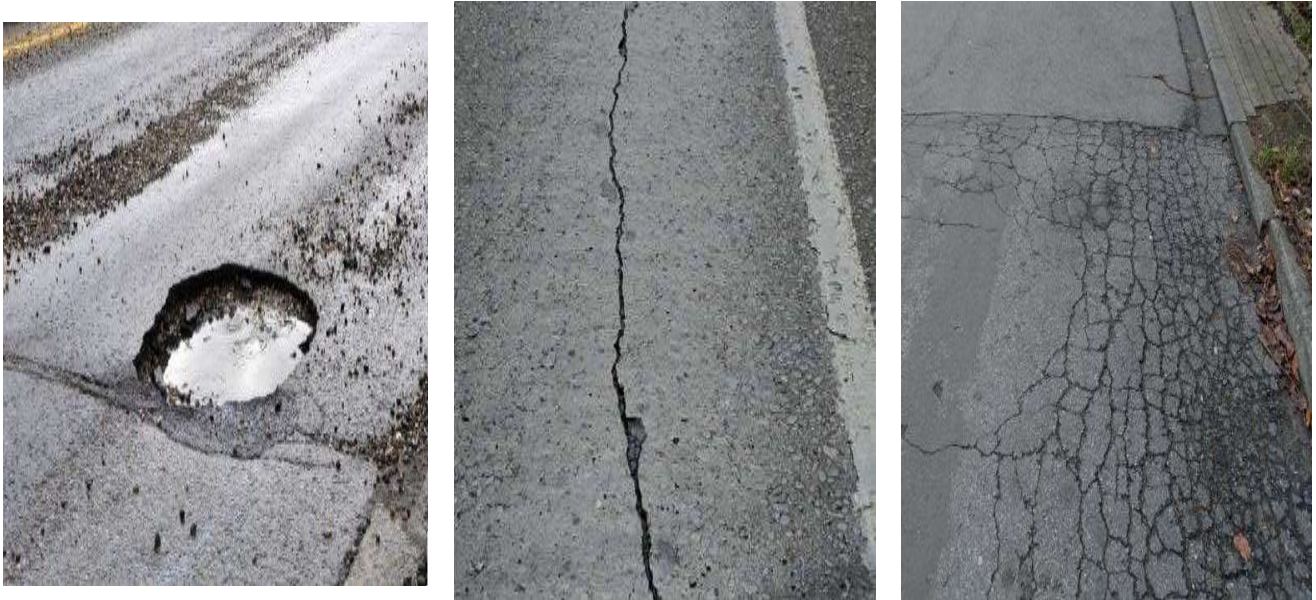
Figure 1- 4 Exemples de dégradations superficielles
