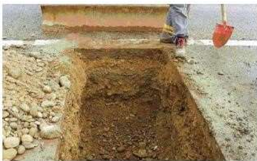
Figure 1- 9 Exemple de sondage de chaussée souple
