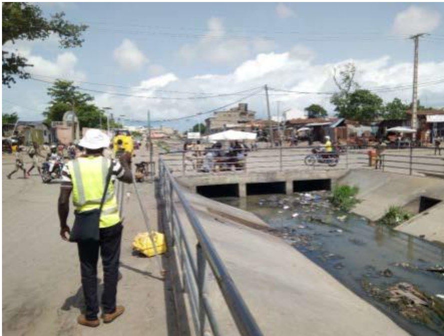
image 8 :Equipe topographique avec une station totale en en activité dans le bassin Q (CEG du LAC)
