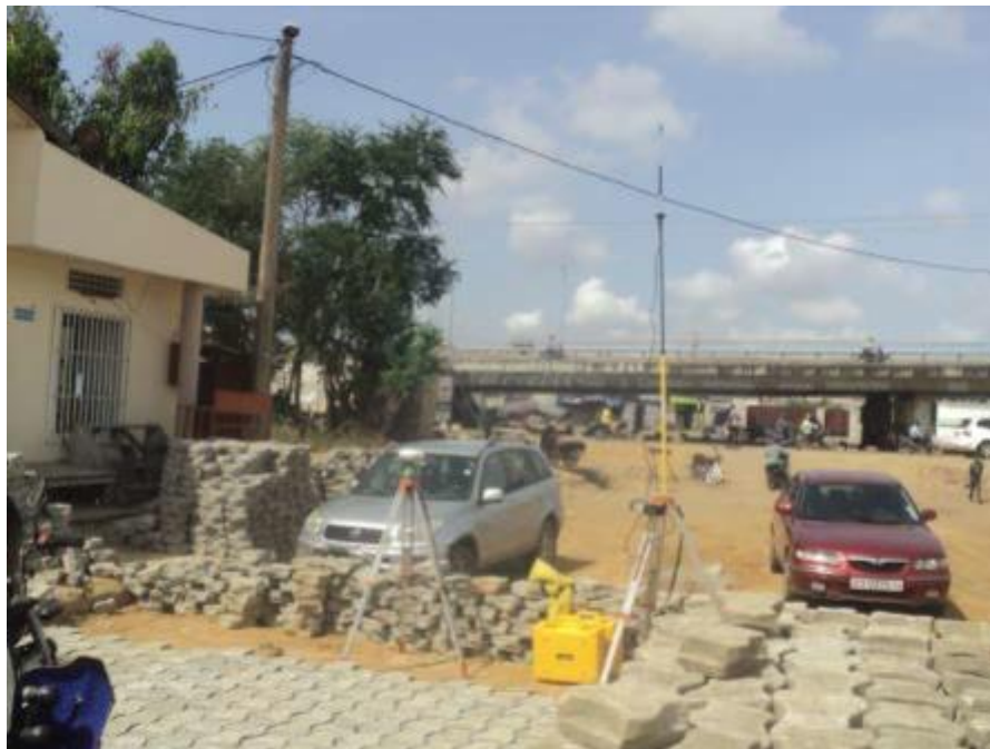
Image 9 : Equipe topographique avec une station GPS différentiel en en activité dans le bassin AAc (Houéyiho)
