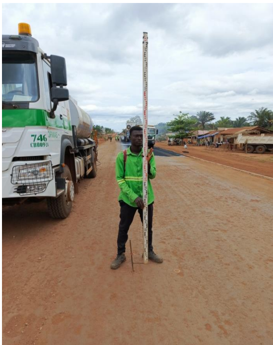
Photo 24 : Photo montrant l'implantation des cotes des potences à l'axe pour appliquer le grave bitume.
