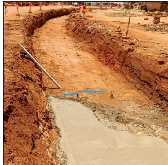
Photo 20: Photo montrant le fond de fouille et caniveau construit
