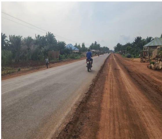
Photo 21 : Photo montrant une couche de PST réglée Septembre 2024
