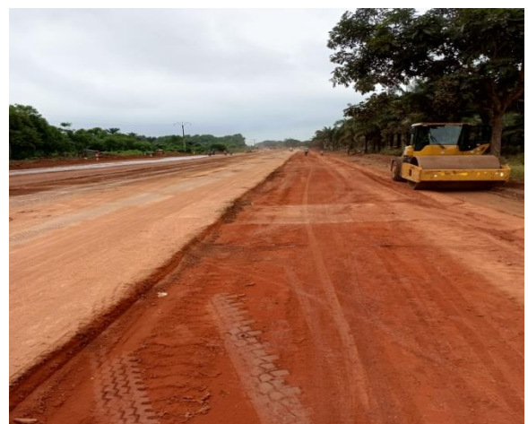
Photo 21 : Photo montrant une couche de PST réglée Septembre 2024
