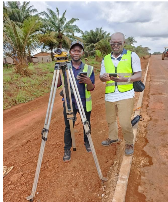
Photo 24 : Photo montrant l'implantation des cotes des potences à l'axe pour appliquer le grave bitume.
