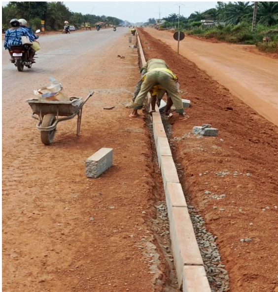
Photo 23 : Photo montrant l'implantation et pose bordures Septembre 2024
