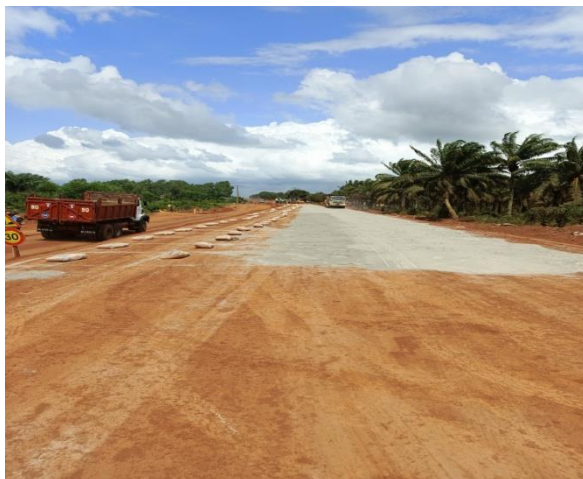
Photo 22 : Photo montrant la réalisation de la couche de fondation
