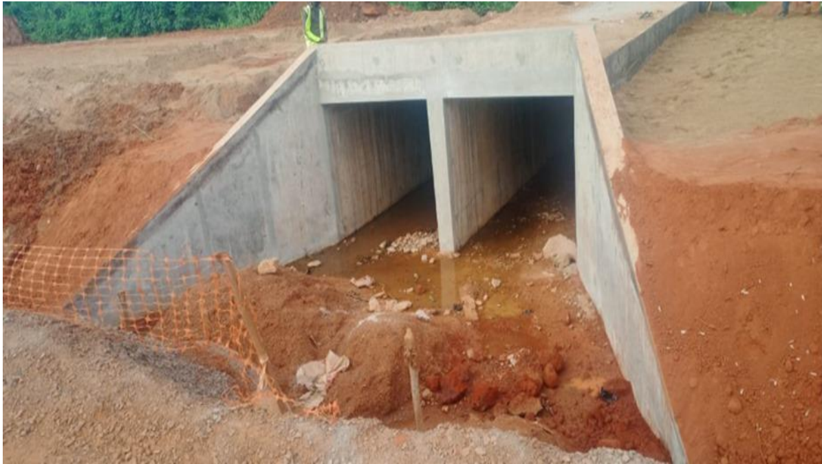
Photo 18 : Photo montrant un dalot construit
