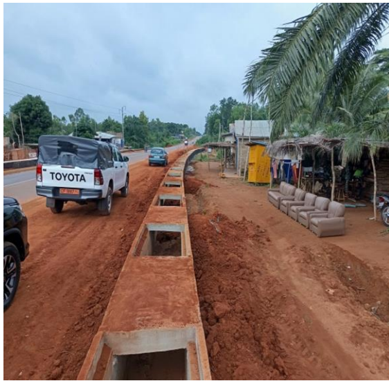
Photo 20: Photo montrant le fond de fouille et caniveau construit
