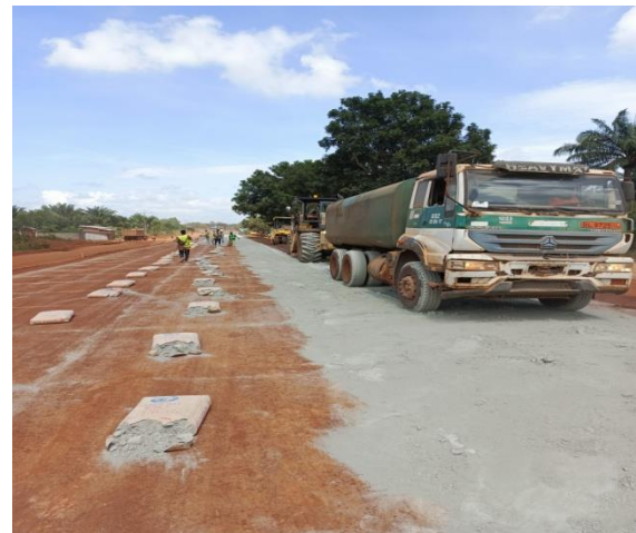
Photo 22 : Photo montrant la réalisation de la couche de fondation
