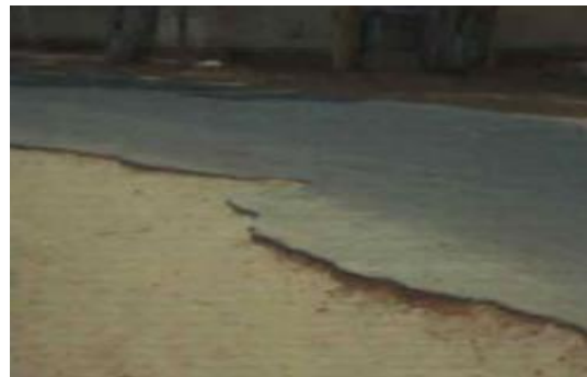
Figure 20 : Epaufures de grande ampleur
