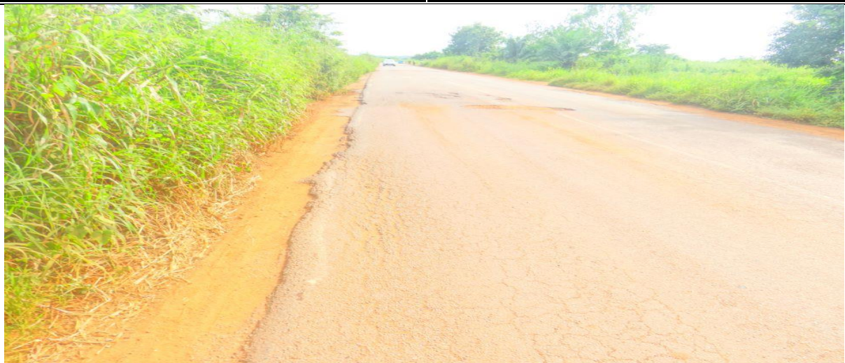
Figure 43 : Photo des arrachements
