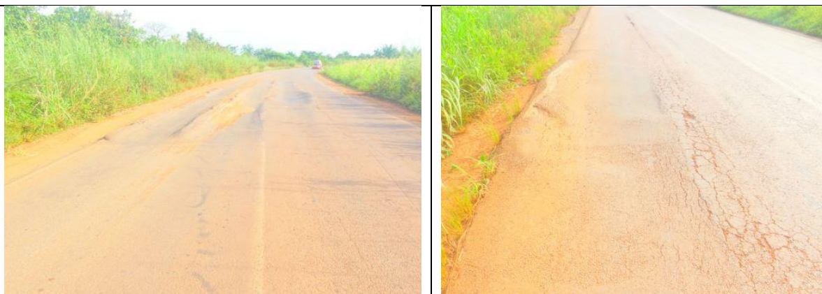
Figure 34 : Photo des bourrelets
