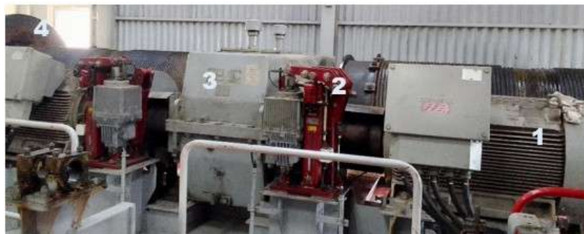
FIGURE 1.5 – Treuil et moteurs de levage ou hoist
