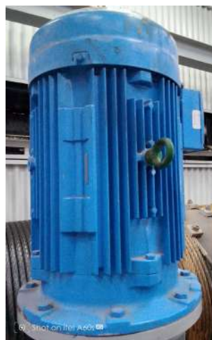
FIGURE 2.3 – Moteur électrique de secours du levage
