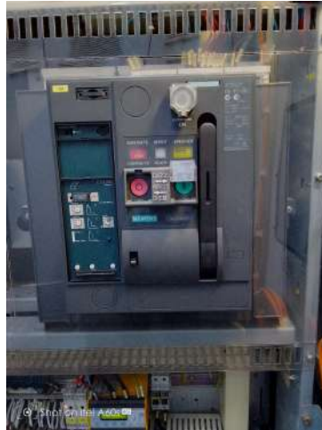
FIGURE 2.5 – Contacteur principal du portique
