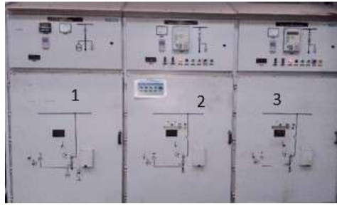
FIGURE 1.8 – le dispositif de la translation ou gantry 1 : Transfo arrivée, 2 : Transfo Départ, 3 : transfo auxiliaire
