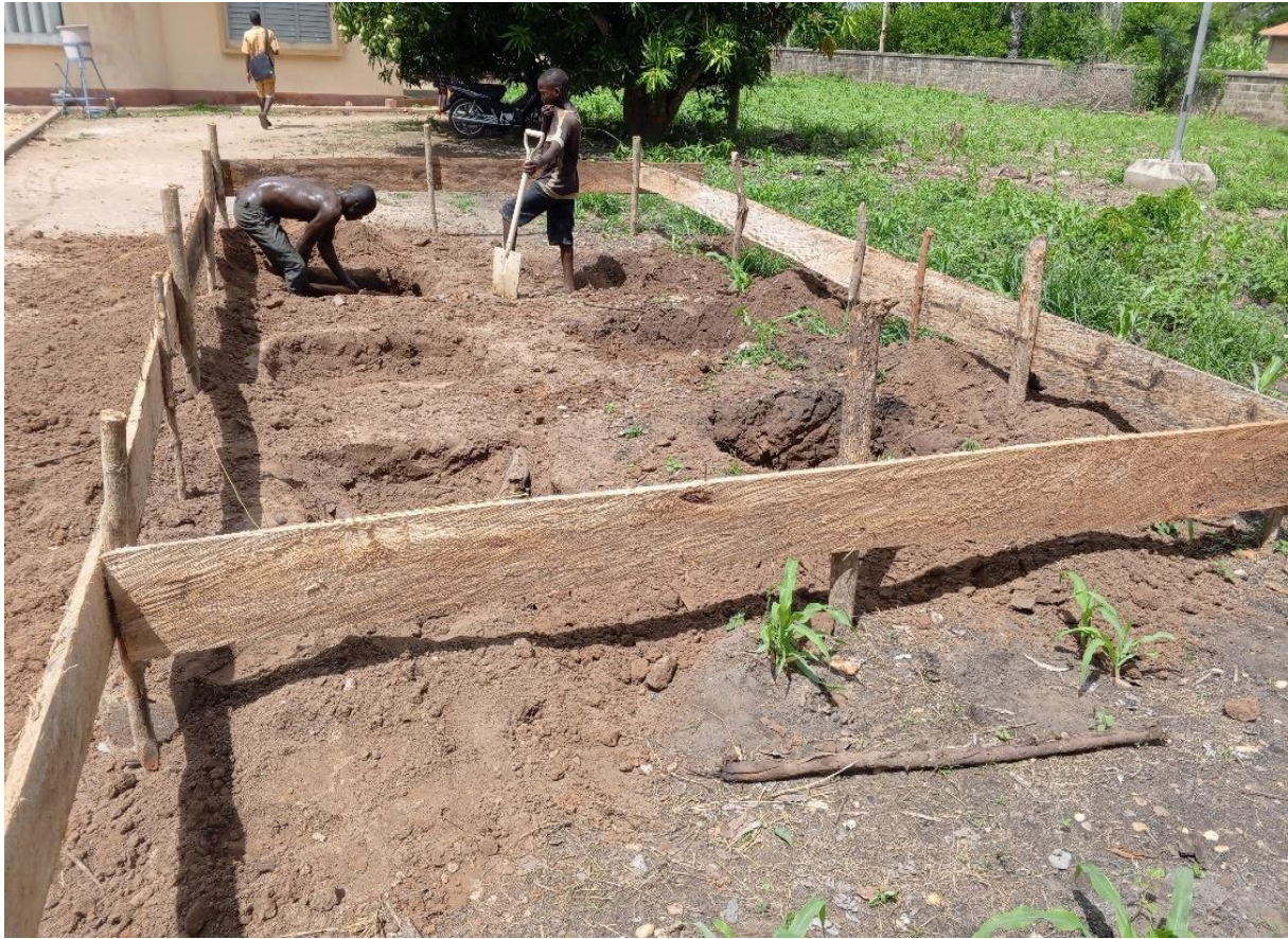
Photo 19 : Implantation de l'ouvrage
