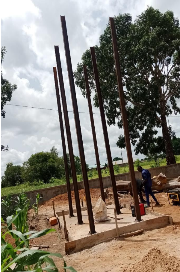
Photo 24 : Réalisation des poteaux Source : YAROU ISSA K.
