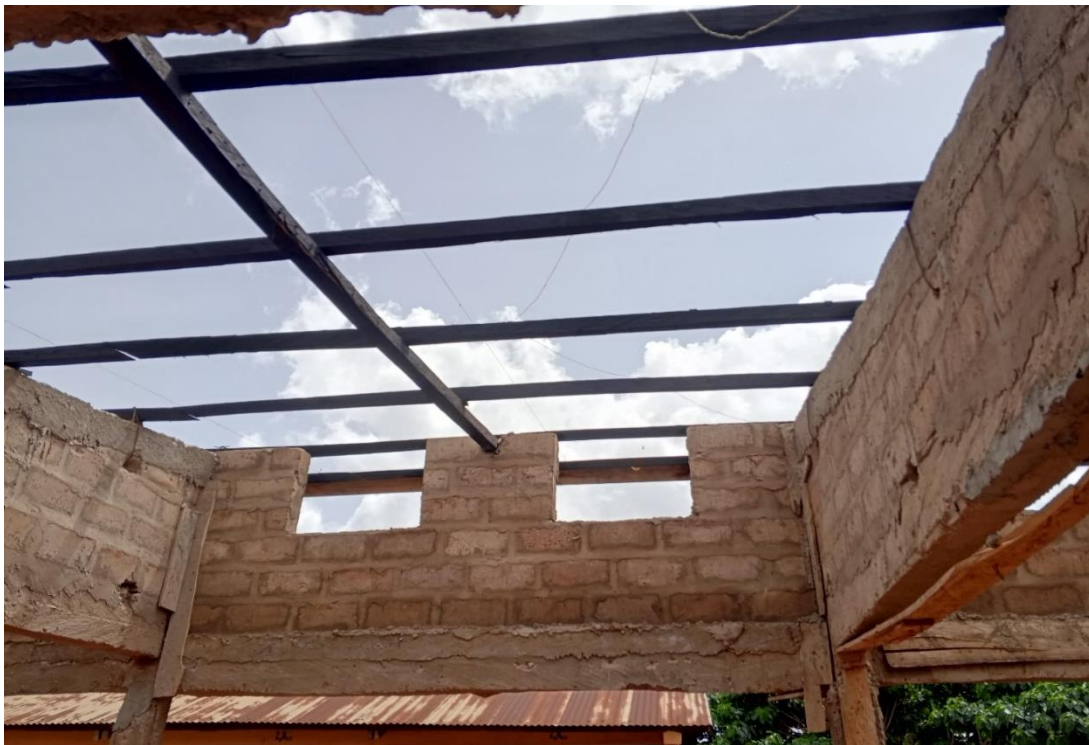
Photo 16 : Réalisation de la charpente
