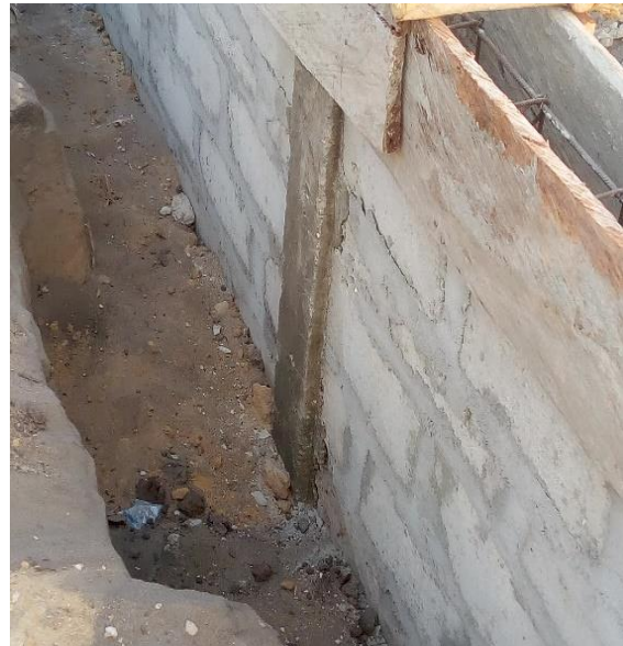
Photo 9 : Réalisation de poteau amorce
