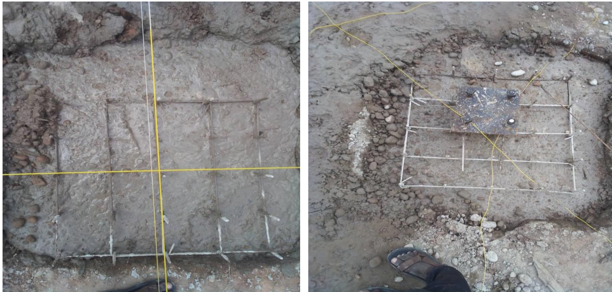
Photo 22 : Semelle isolées coulées
