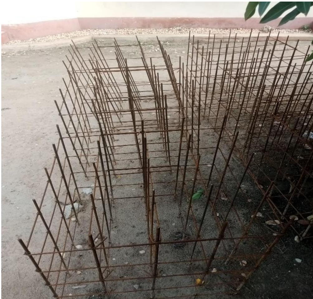
Photo 21 : Ferrailage des semelles isolée Source : YAROU ISSA K.
