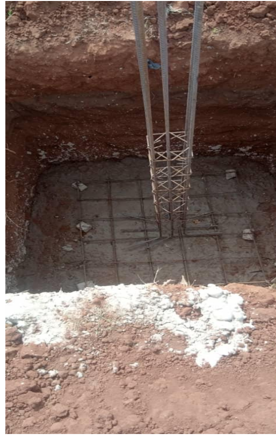
Béton de propreté sous smelle isolée
