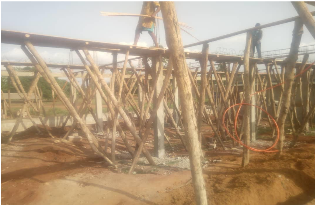
Photo 10 : Pose des fonds de poutres Source : YAROU ISSA K.
