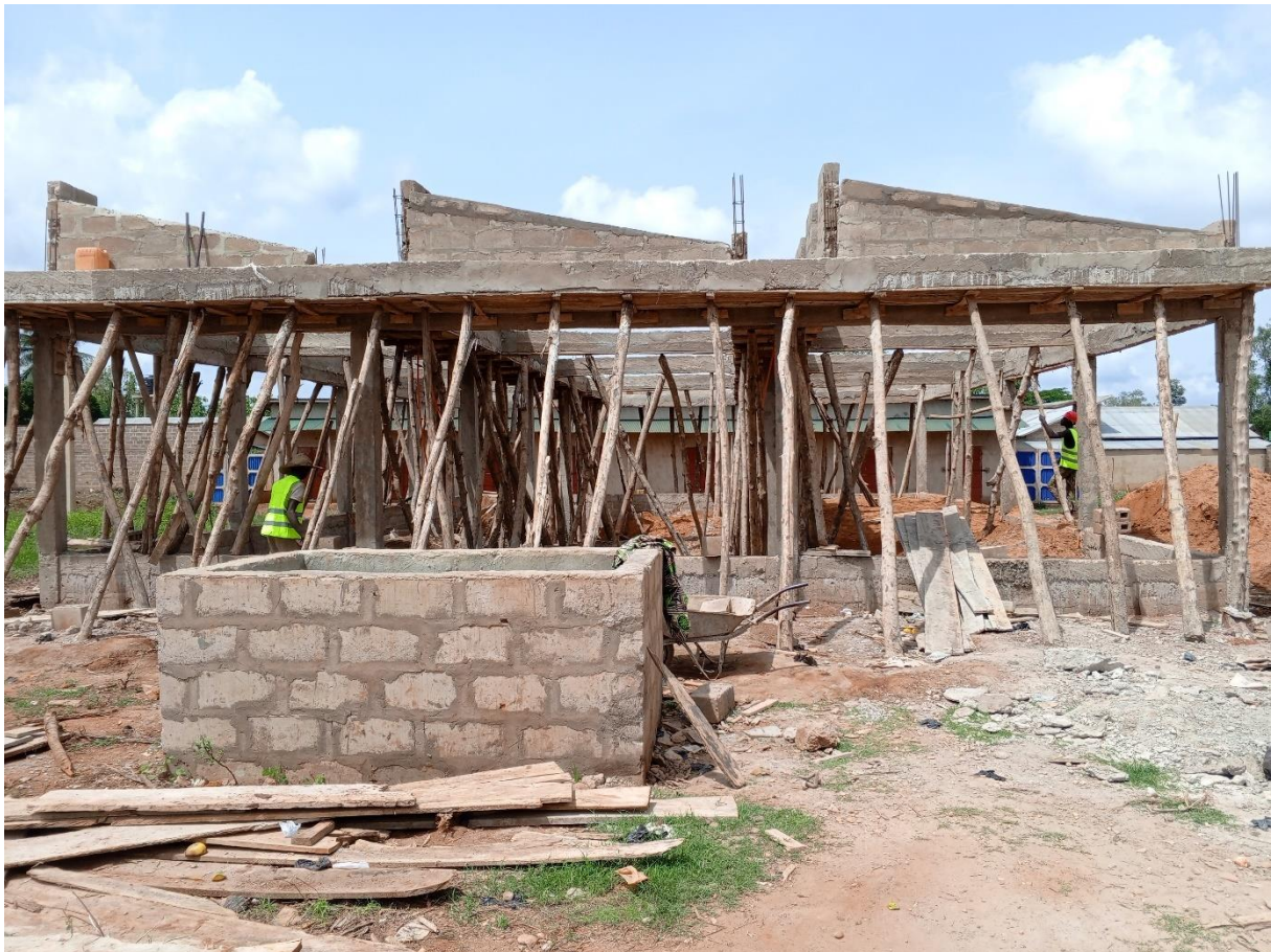
Photo 13 : Réalisation des murs pignons et chainages rampants
