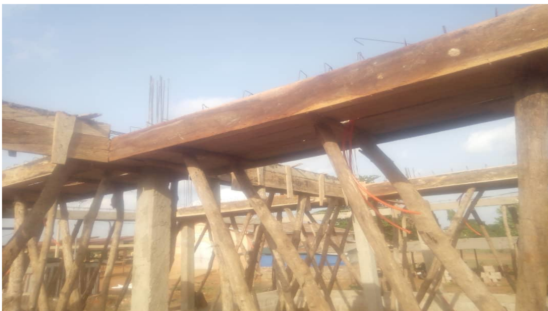
Photo 11 : Coffrage des poutres Source : YAROU ISSA K.
