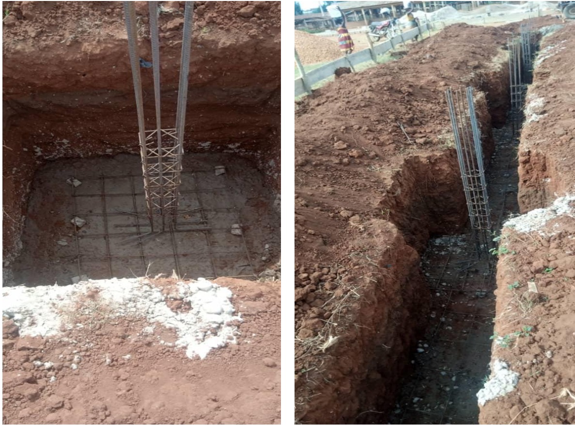
Photo 7 : Implantation des poteaux amorces
