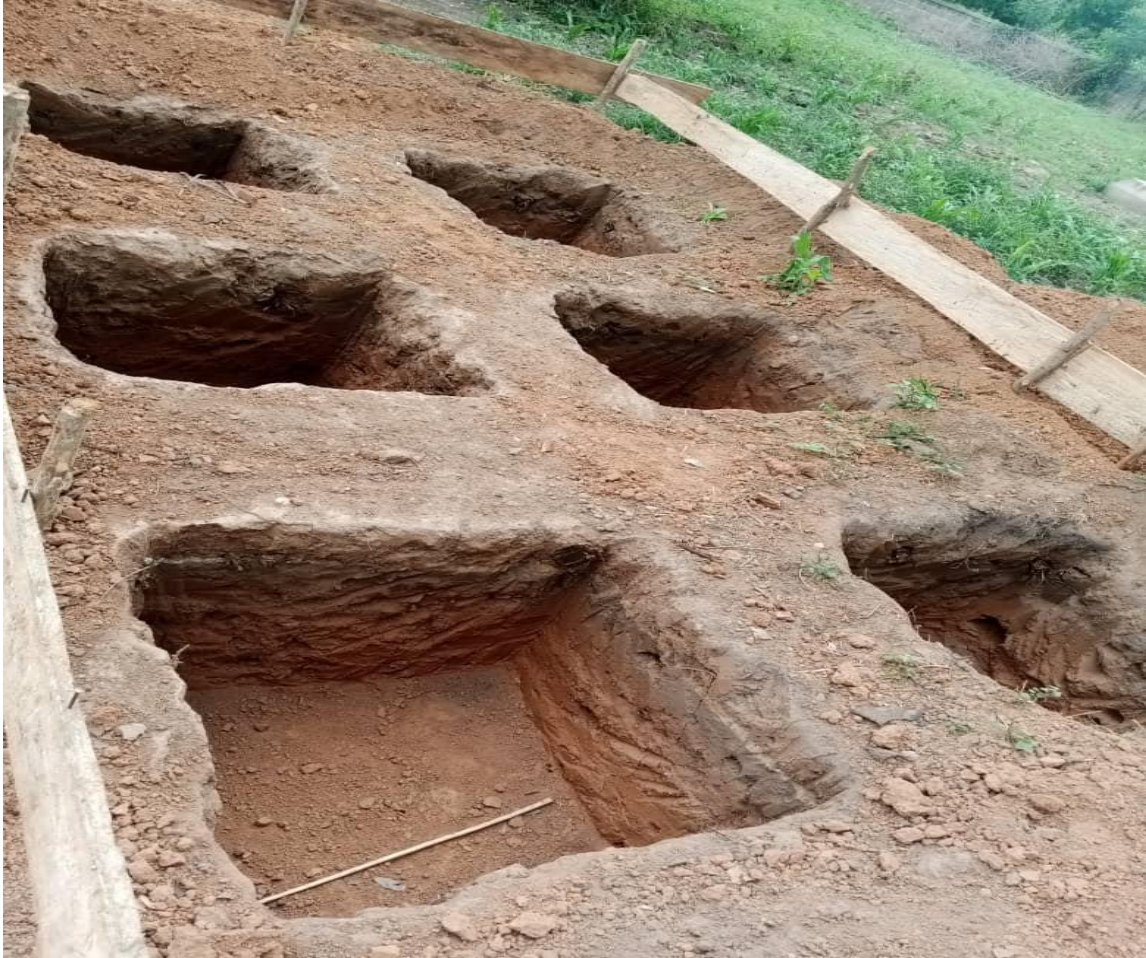
Photo 20 : Réalisation des fouilles
