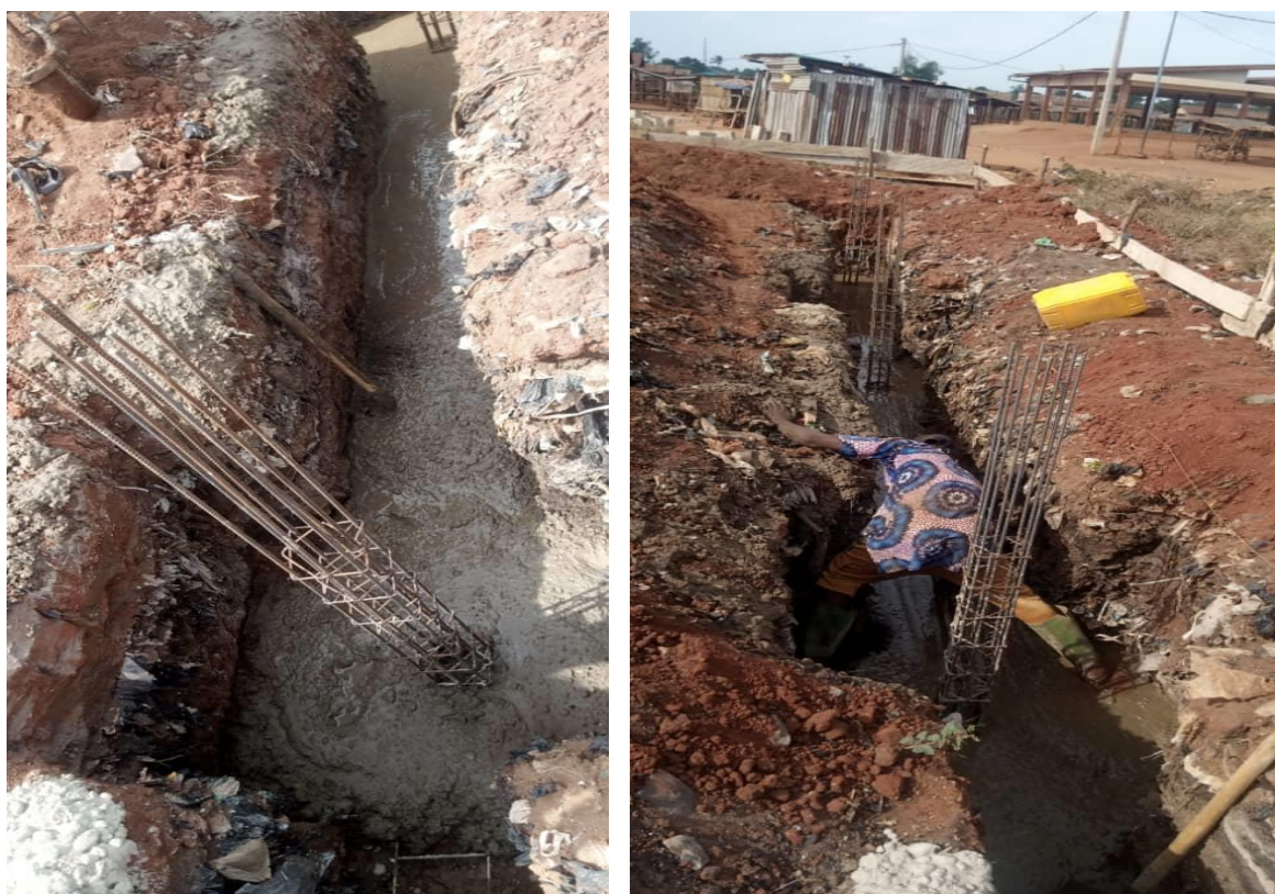
Photo 8 : Réalisation du béton de fondation
