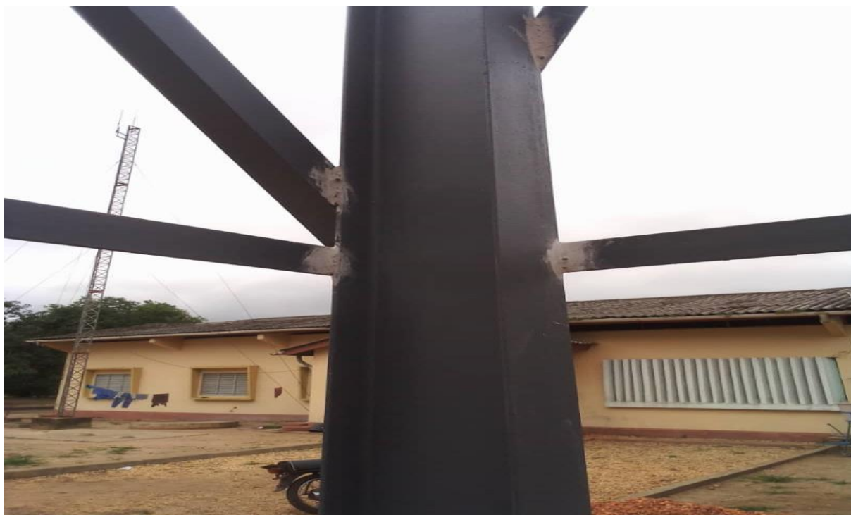
Photo 26 :Réalisation des cornières
