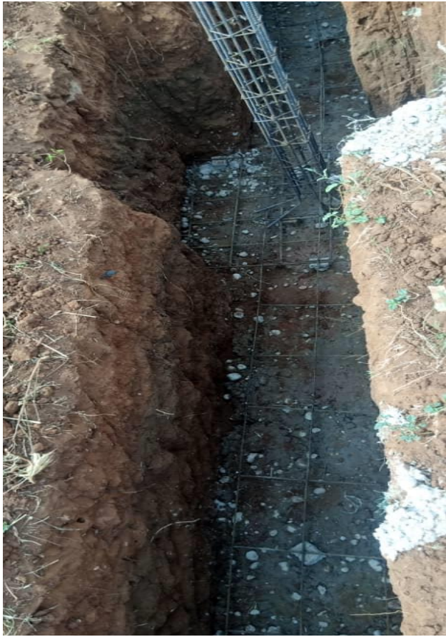
Béton de propreté sous semelle filante
