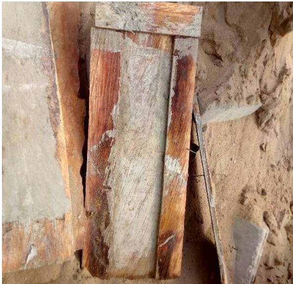
Photo 9 : Réalisation de poteau amorce
