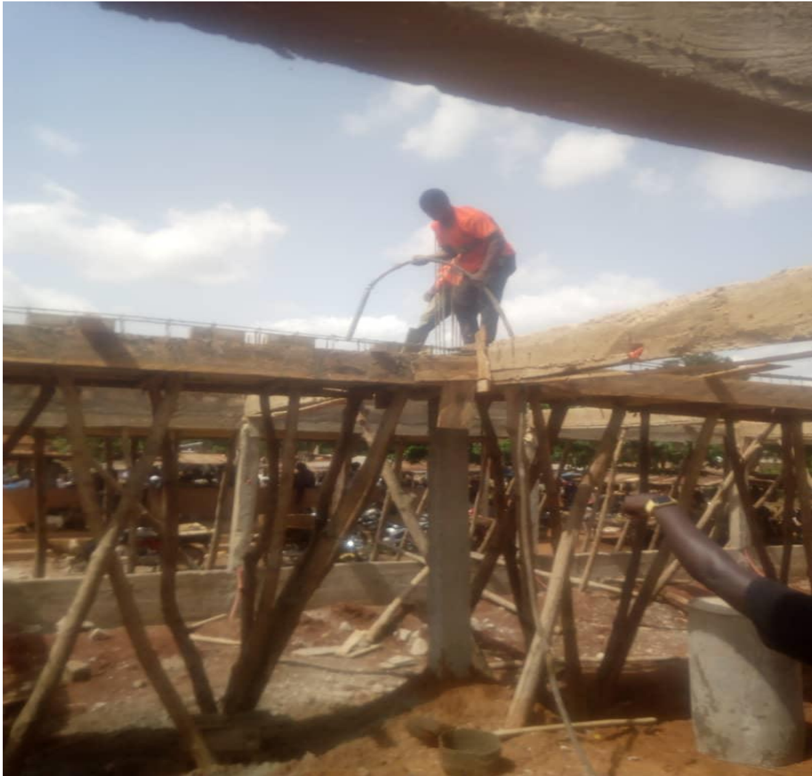
Photo 12 : Coulage des poutres
