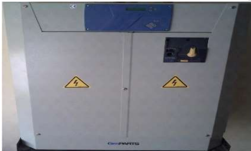
Figure 3.24 : Raccordement des groupes sur le réseau électrique
