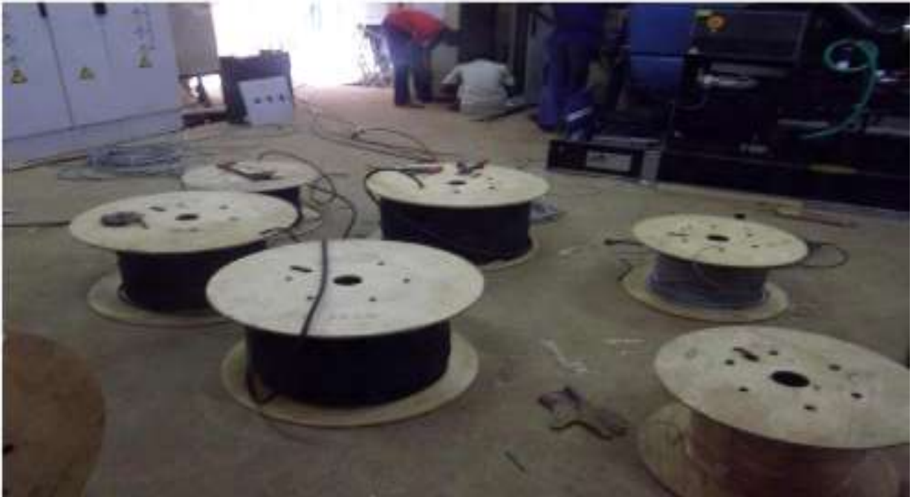
Figure 3.23 : Différents câbles utilisés pour le câblage des circuits
