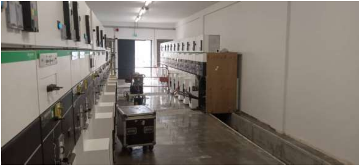
Figure 3.3 : Local des cellules HT
