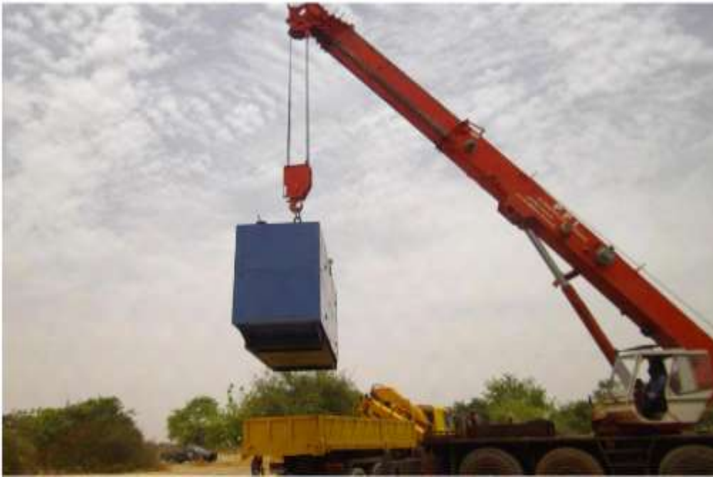
Figure 3.22 : Elingage du groupe électrogène
