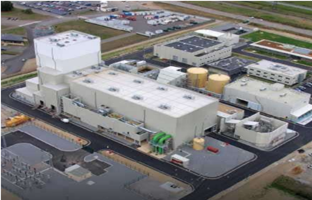
Figure 2.2 : Central électrique a cycle combiné
