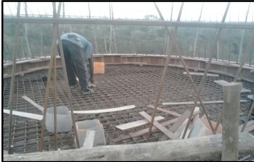
Photo 7: ferrailage de la poutre et de la dalle de fond.
