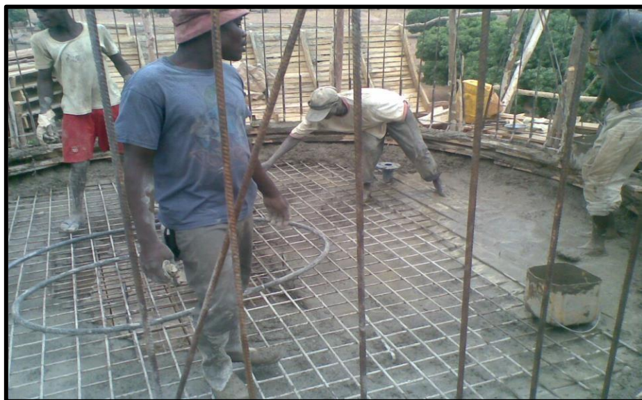
Photo 8: Coulage de la poutre et la dalle de fond
