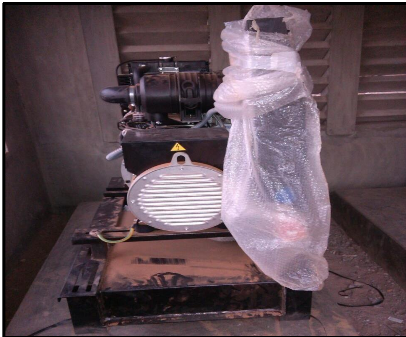
Photo 17: groupe électrogène de type TR2
