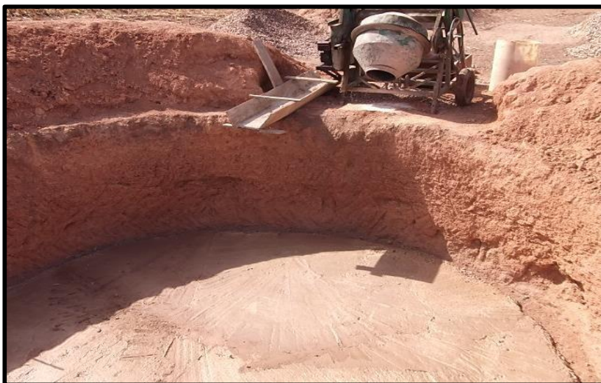
Photo 1: Coulage du Béton de propreté
