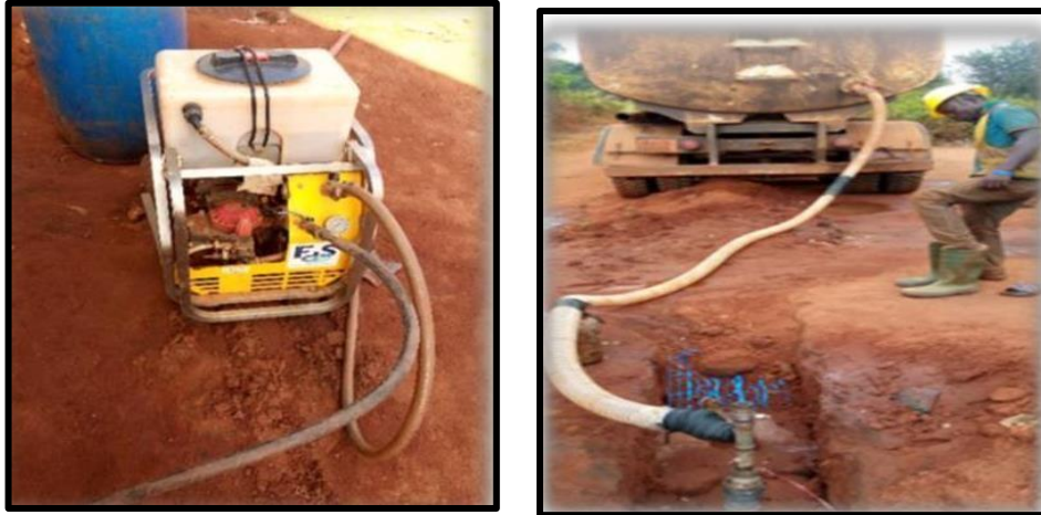
Photo 14: Pompe à éprouve et mise en eau du réseau
