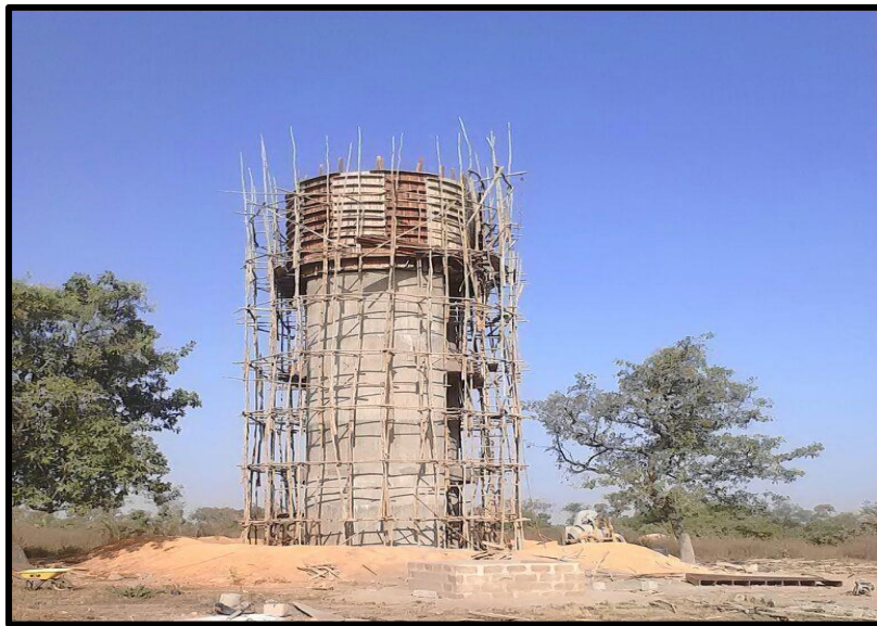
Photo 9: Ferrailage et Coffrage du la cuve du château d'Eau
