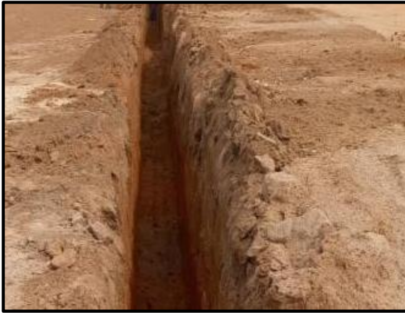
Photo 10: Réalisation du fond de fouille
