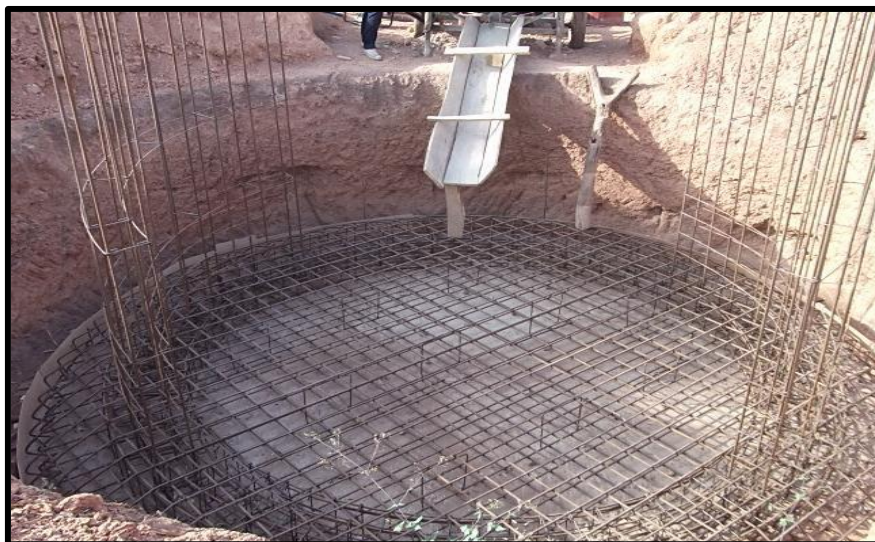
Photo 2: Ferrailage et Coffrage du radier
