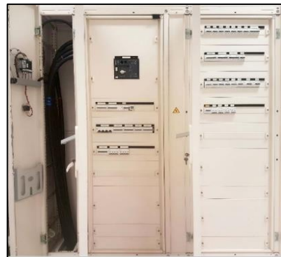
Photo 12 : Le tableau de distribution 230/400Vac
