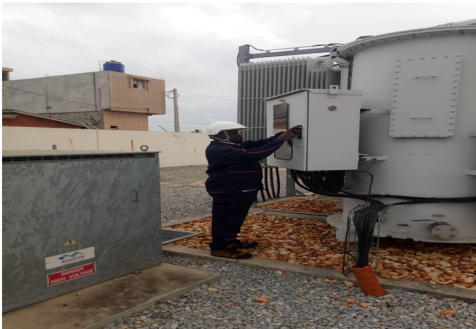
Photo2 : Relevé des températures des enroulements et de l'huile
