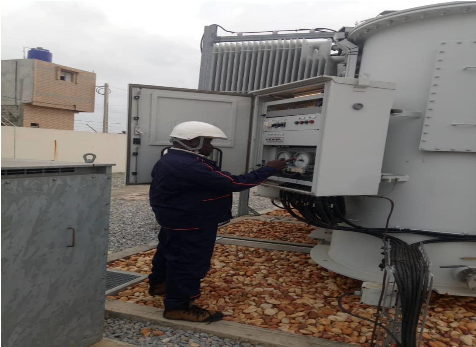
Photo4 : Relevé des températures des enroulements et de l'huile
