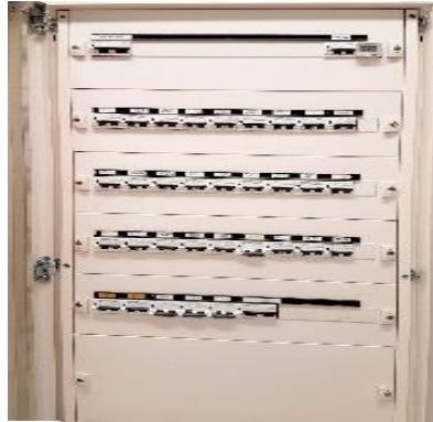
Photo 13 : Le tableau de distribution 48Vcc
