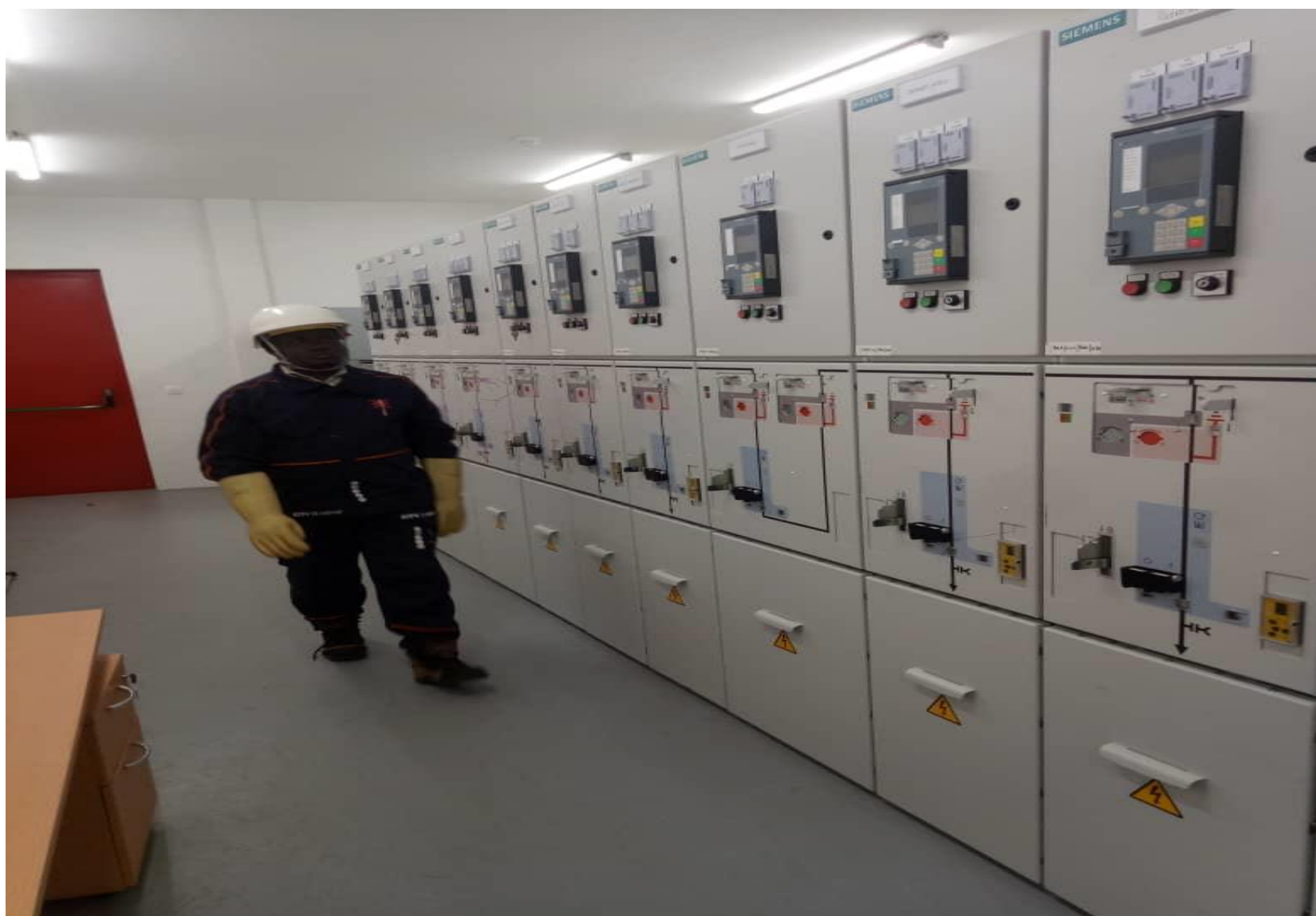
Photo6 : Salle Moyenne Tension (MT) pour une opération de consignation du départ Atrokpocodji pour travaux
