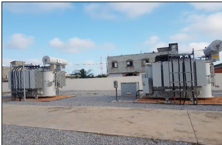
Photo 5 : Vue des transformateurs HTB/HTA du poste de Cococodji
