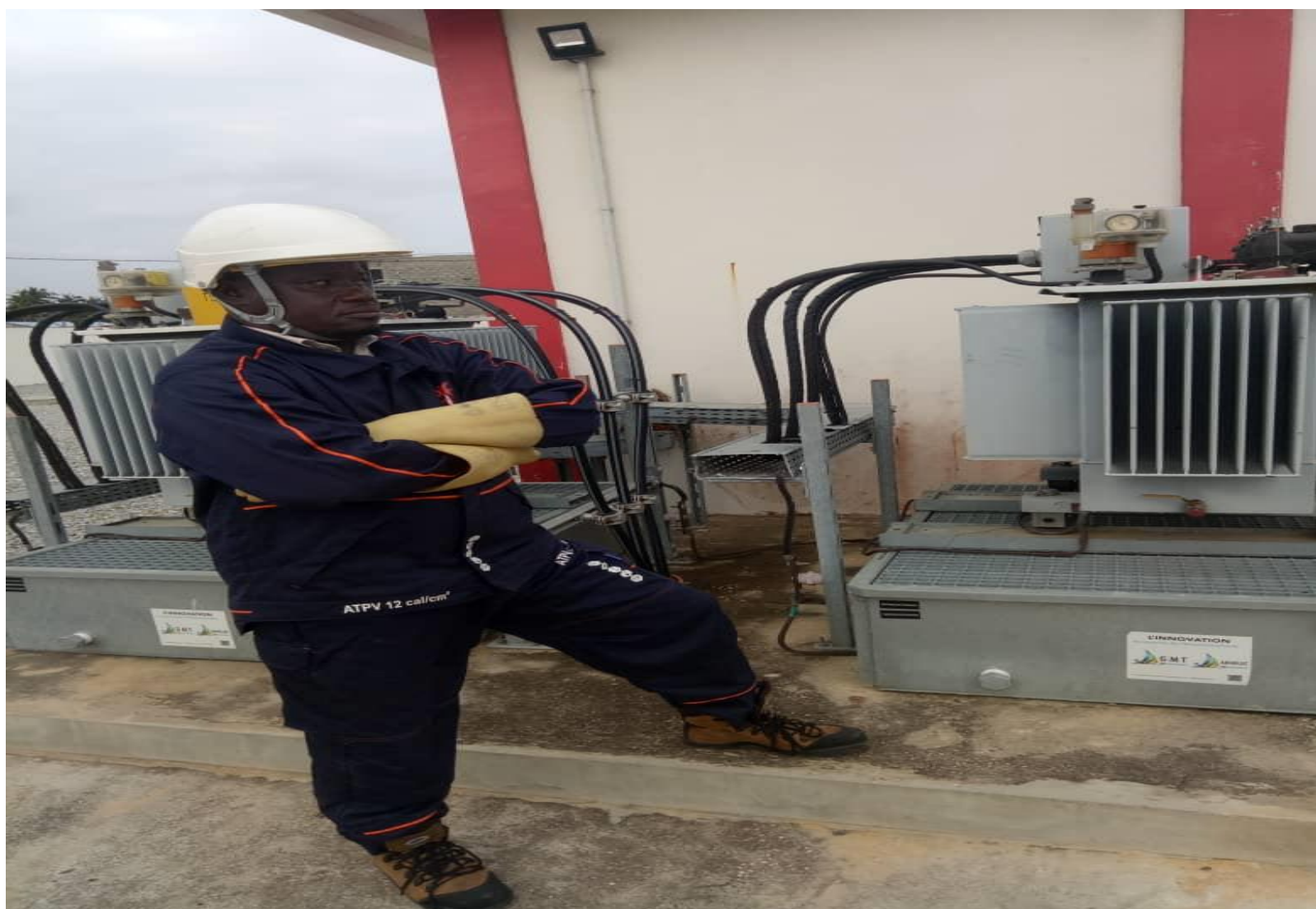
Photo8 : Observation visuelle des paramètres des enroulements et de l'huile des TSA
