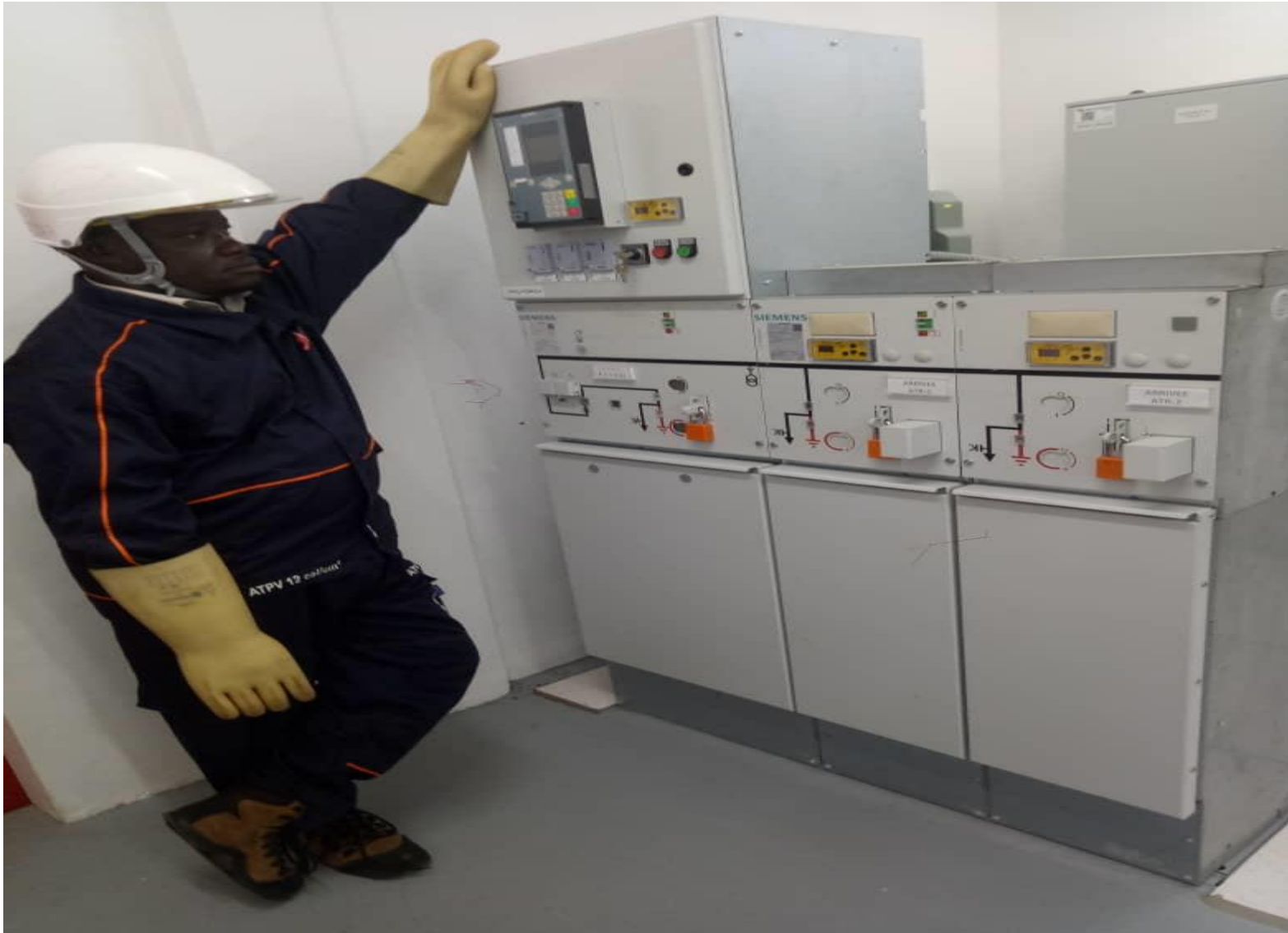
Photo5 : Acquiescement d'un défaut sur le départ déclenché
