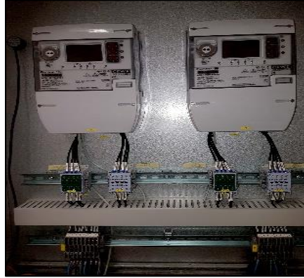
Photo 16 : Compteurs d'énergie
