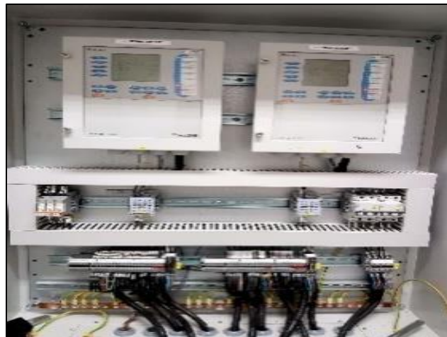
Photo 17 : Régulateur de tension
