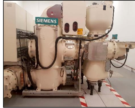
Photo 4 : Travée arrivée ligne
