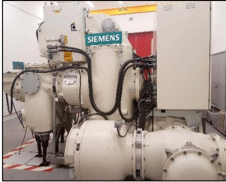
Photo 3 : Travée transformateur
