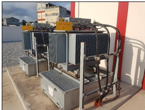
Photo 9 : Les transformateurs de service auxiliaire
