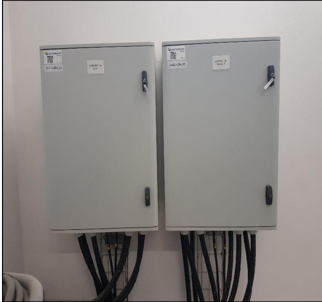
Photo 10 : Les coffrets basse tension des TSA
