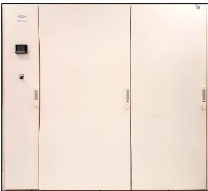
Photo 12 : Le tableau de distribution 230/400Vac
