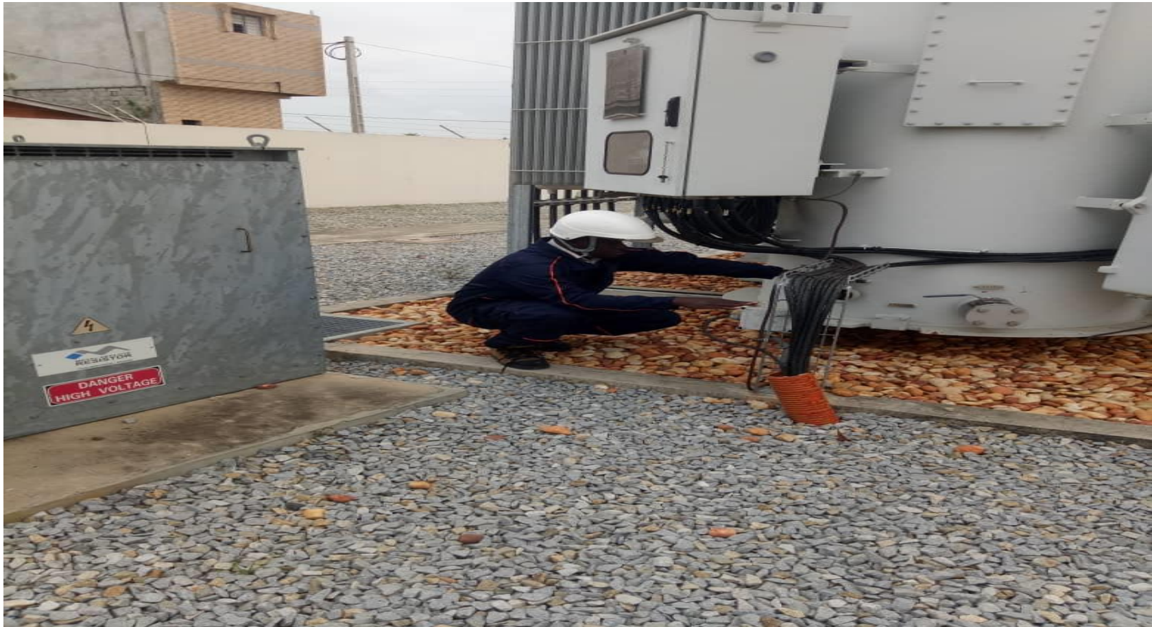
Photo1 : Contrôle visuelle de vanne d'huile
