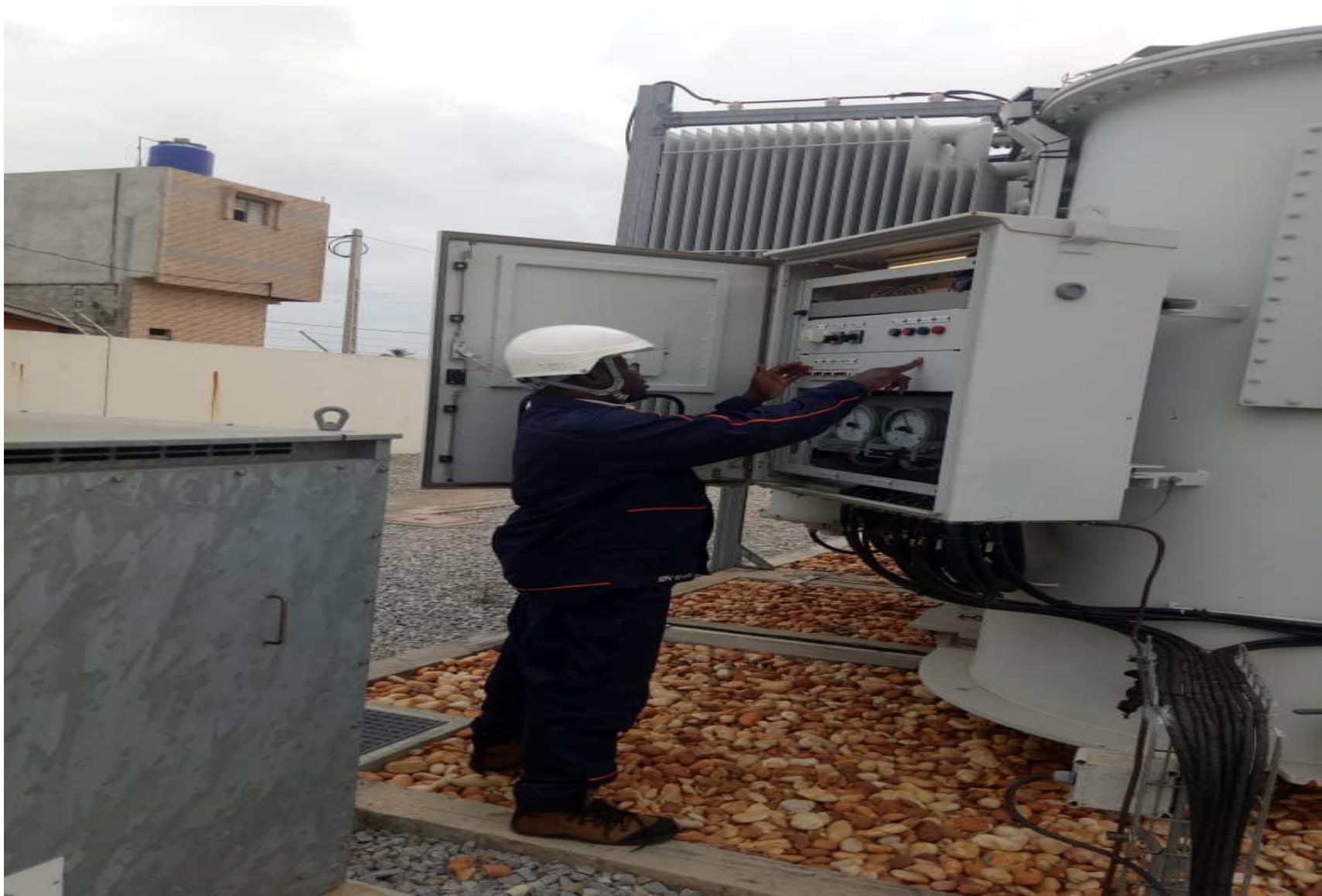
Photo3 : Relevé des températures des enroulements et de l'huile
