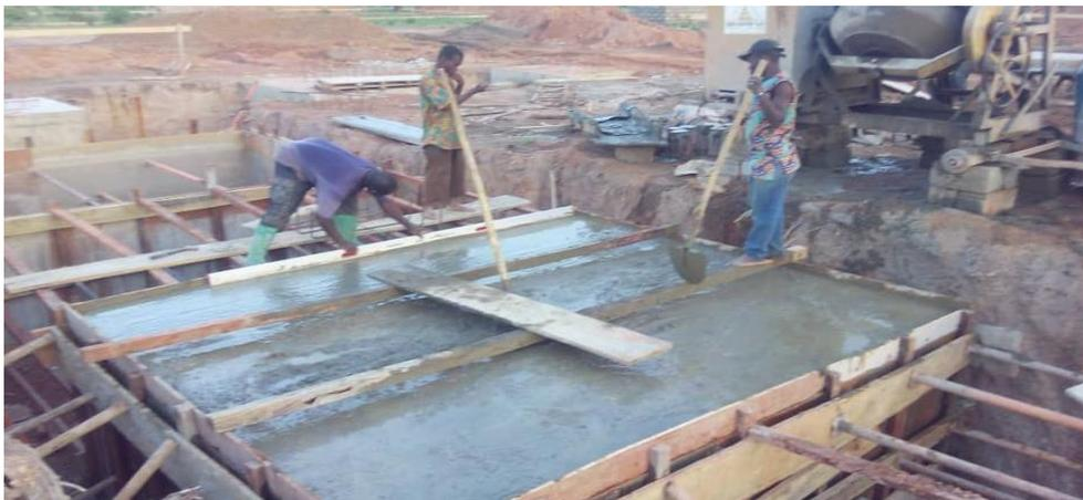
Figure 13 : gros béton coulé dans des caisses de coffrage
