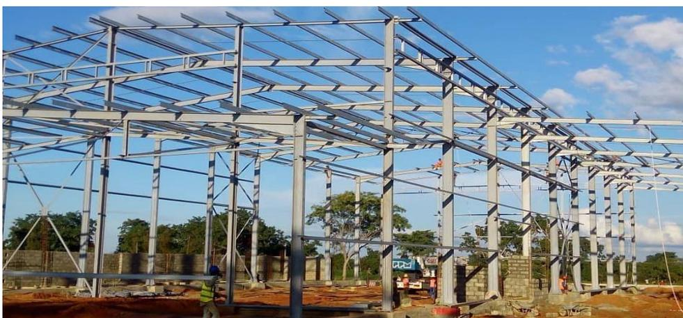
Figure 17 : parpaing en élévation pour une structure métallique
