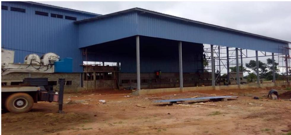
Figure 18 : bardage en tôle laquée d'une structure métallique
