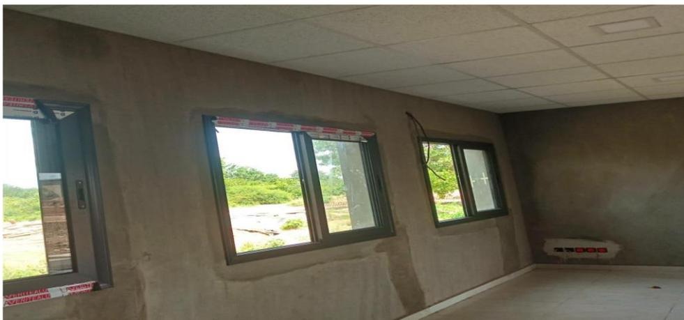
Figure 20 : montage de fenêtre en baie vitrée coulissante
