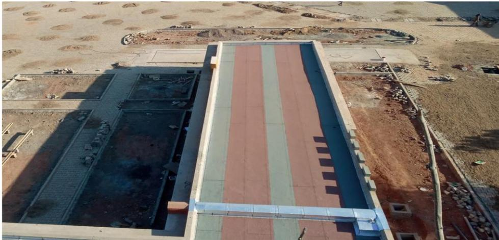
Figure 27 : réalisation de la couche finale d'étanchéité
