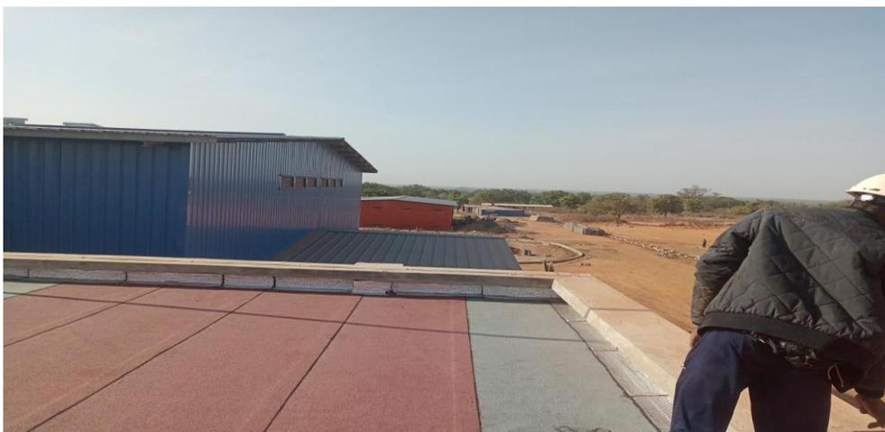
Figure 26 : réalisation de la couche finale d'étanchéité
