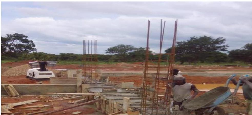
Figure 15 : longrine en béton arme en cours de coulage
