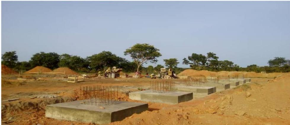
Figure 14 : béton semelle isolée coulée
