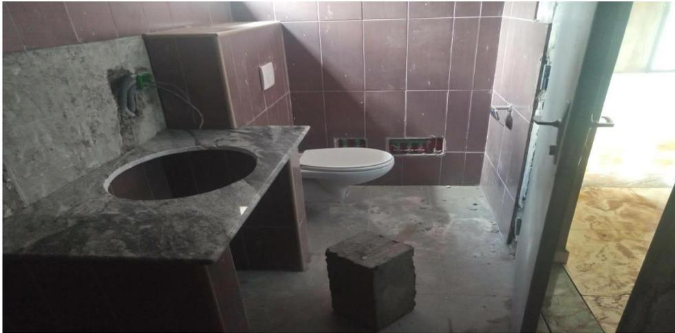
Figure 22 : réalisation du carrelage
