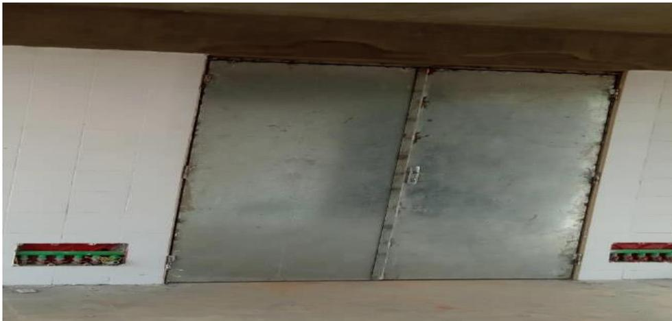
Figure 19 : scellement d'une porte métallique
