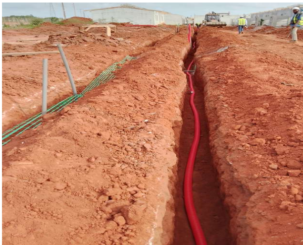
Photo N°10 : Pose de tuyaux du réseau éclairage Public sur le rue N°40 après réception.
