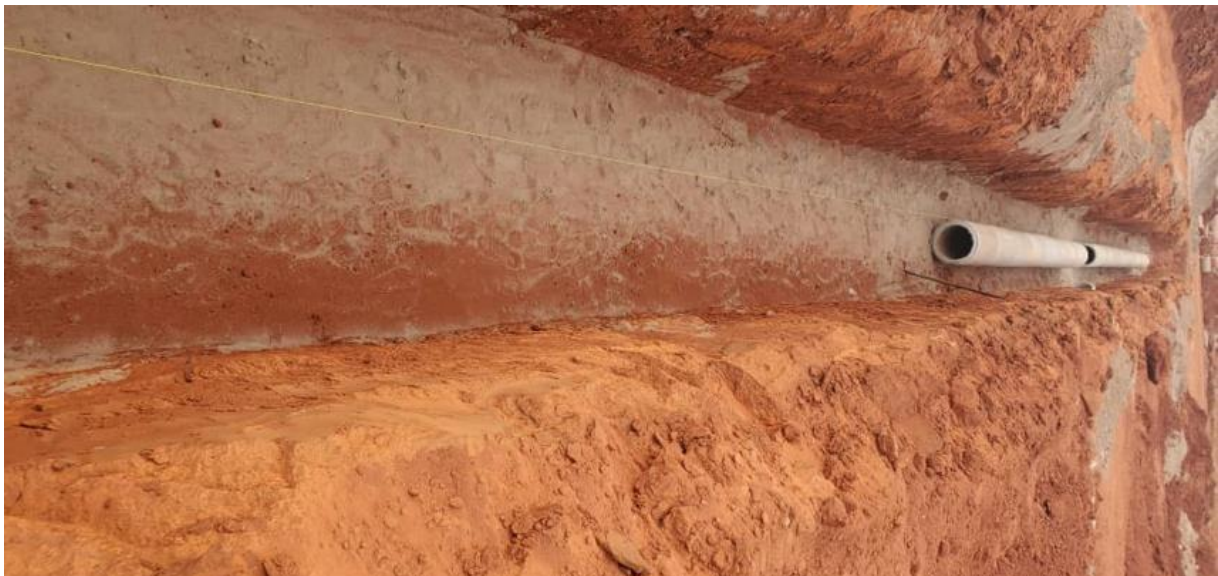
Photo 19: Lit de pose déjà réalisé
