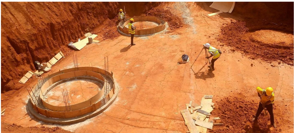
Photo 32: Réglage cote radier
