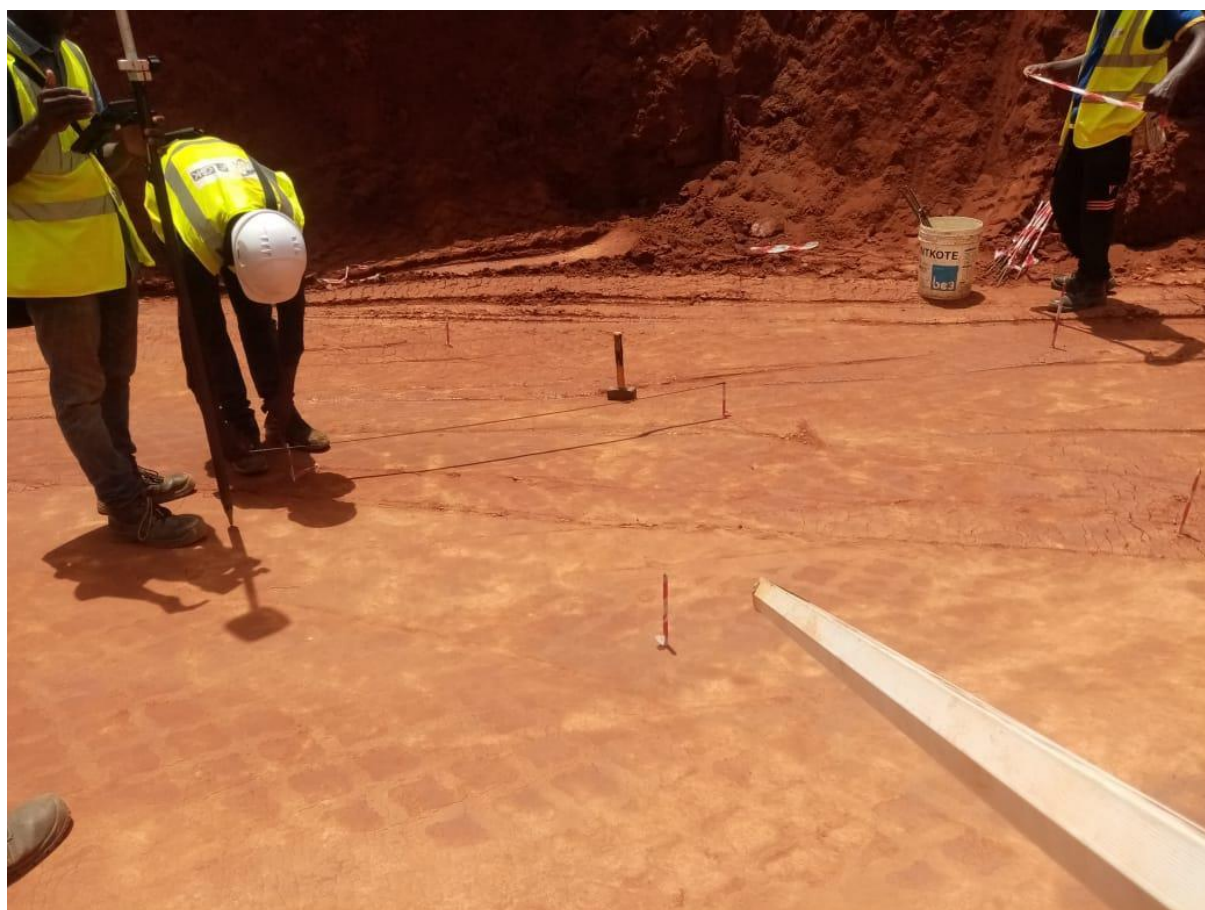
Photo 30 : Implantation d'un puit
