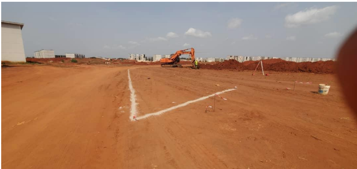
Photo 17: Une fouille implantée
