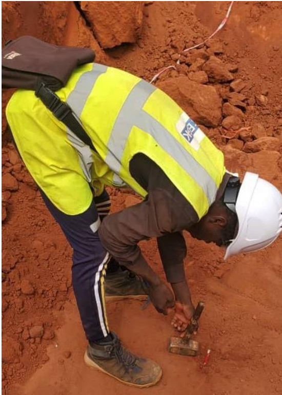
Photo 27: L'implantation des piquets du regard
