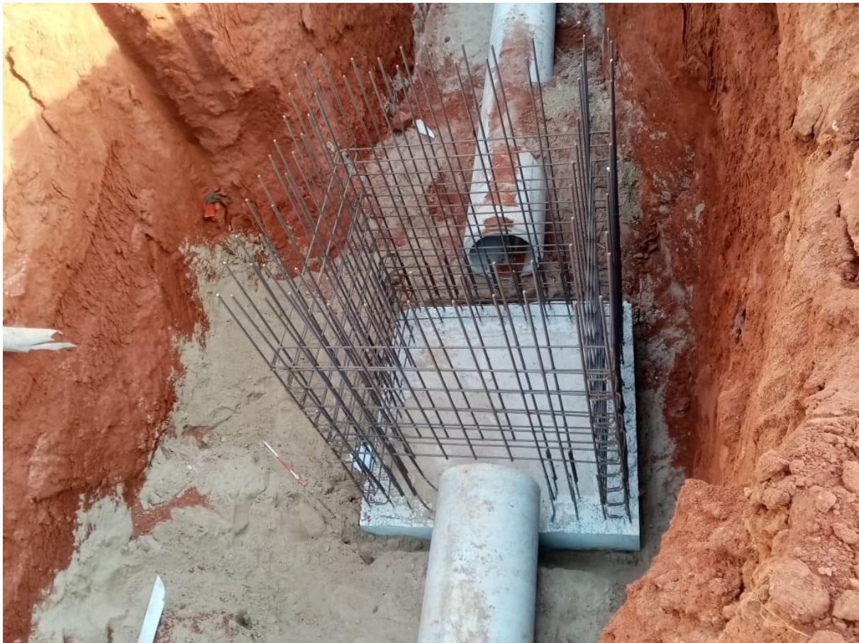
Photo 22: Un radier réalisé
