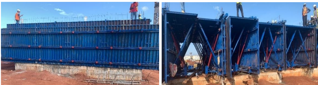
Figure 19 : Coffrage tunnel métallique
