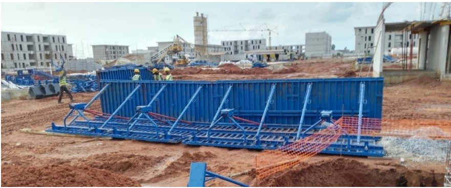
Figure 22 : Demi-coquille d’un coffrage tunnel
