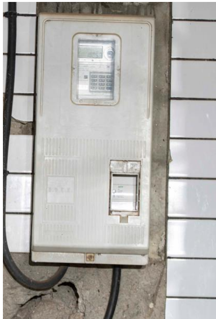
Photo 4 Compteur électrique du bâtiment
