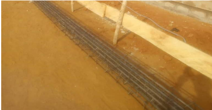
Photo 25 : Ferrailage des chainages (source : MESSOUNA S.)
