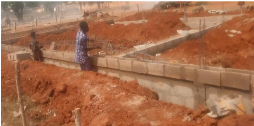
Photo 14 : Mise en place du ferraillement du chaînage après la pose des agglos-coffrages (source : MESSOUNA S.)
