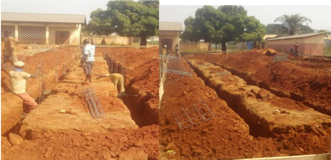
Photo 11 : Implantation des poteaux du bâtiment (source : MESSOUNA S.)
