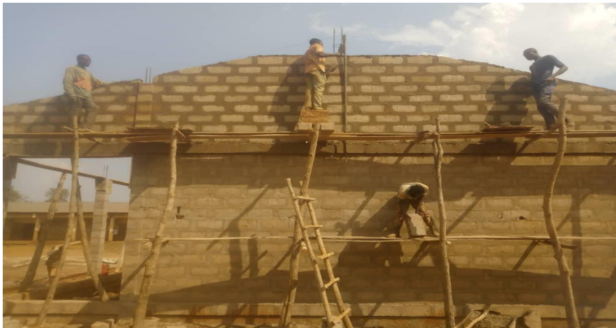
Photo 18 : Réalisation des murs pignons (source : MESSOUNA S.)
