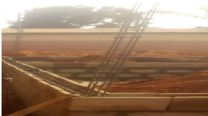
Photo 23 : Rallongement des poteaux (source : MESSOUNA S.)
