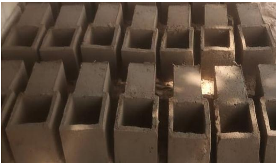
Figure 6 : Moule des agglos-coffrages pour poteaux (source : MESSOUNA S.)
