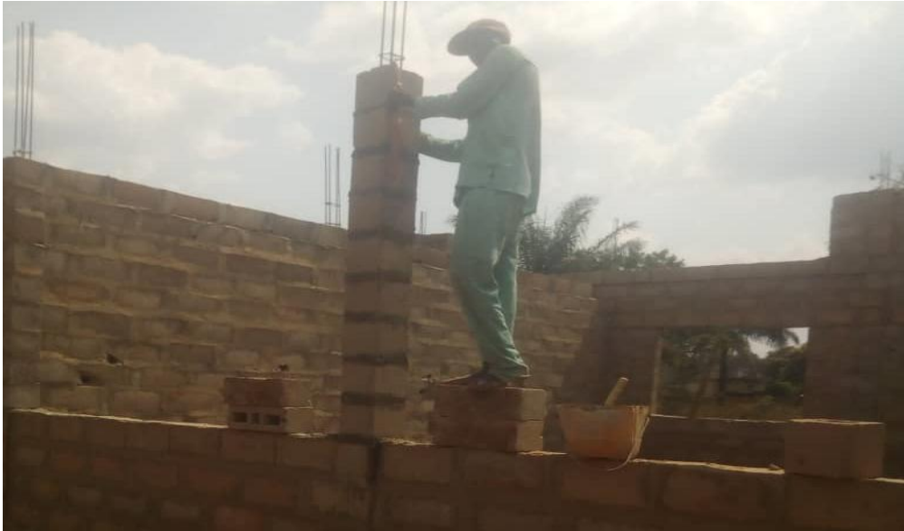
Photo 16 : coulage des poteaux en élévation (source : ADAM A., F.)
