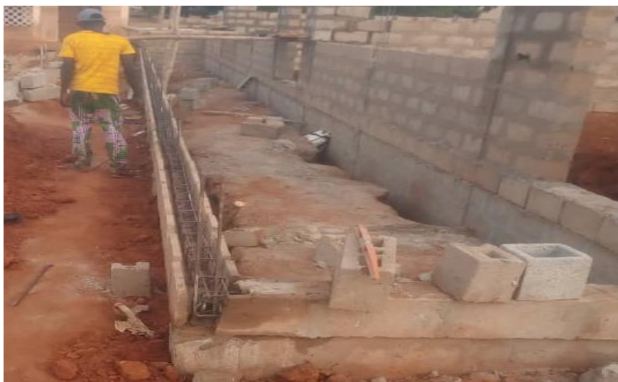
Photo 27 : Pose des ferrailages des chaînages (source : MESSOUNA S.)
