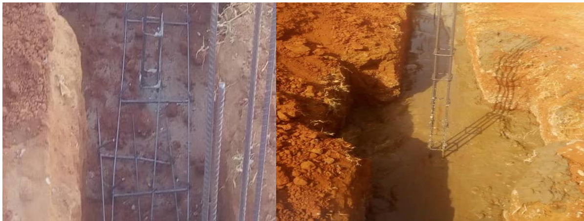
Photo 12 : Pose du ferrailage et coulage des semelles filantes (source : MESSOUNA S.)
