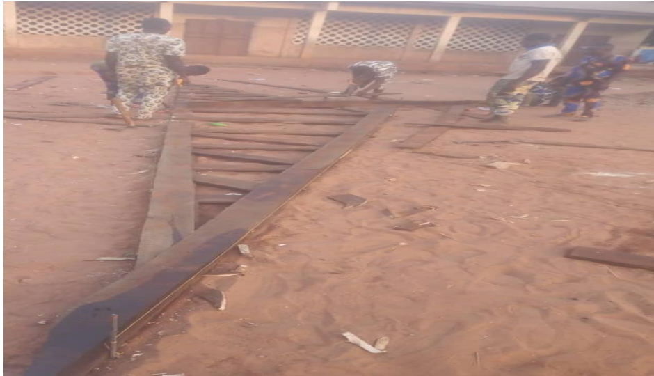
Photo 20 : Réalisation des fermes (source : MESSOUNA S.)
