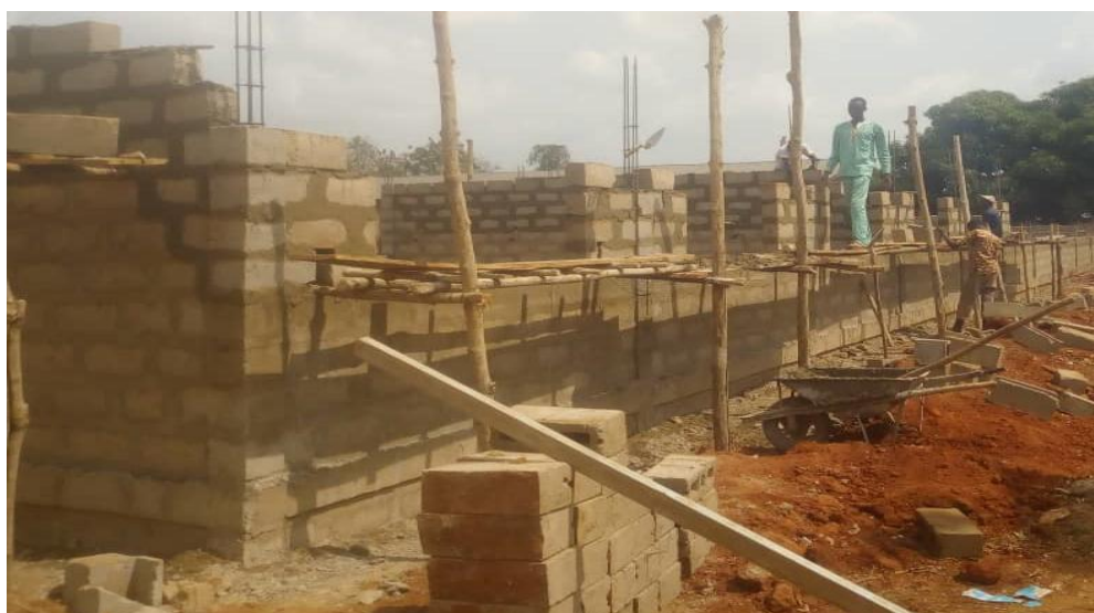
Photo 15 : Élévation des murs (source : MESSOUNA S.)
