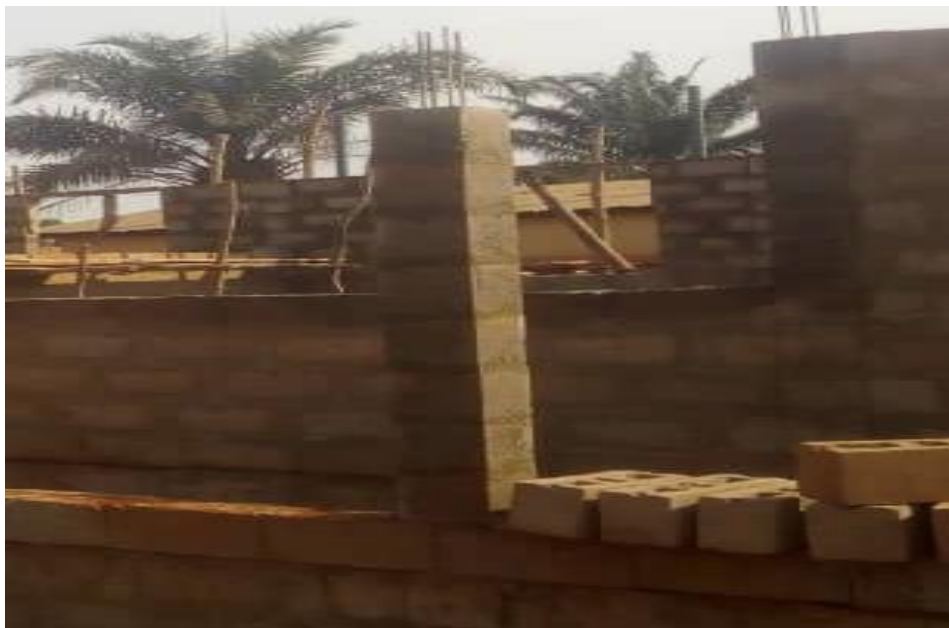
Photo 24 : Pose des aggro-coffrages (source : MESSOUNA S.)
