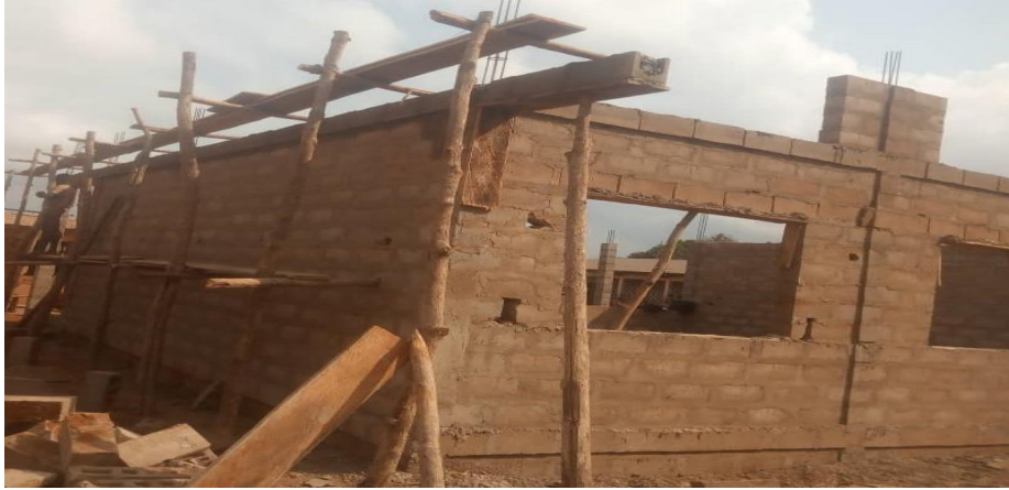
Photo 17 : chainage haut (source : MESSOUNA S.)
