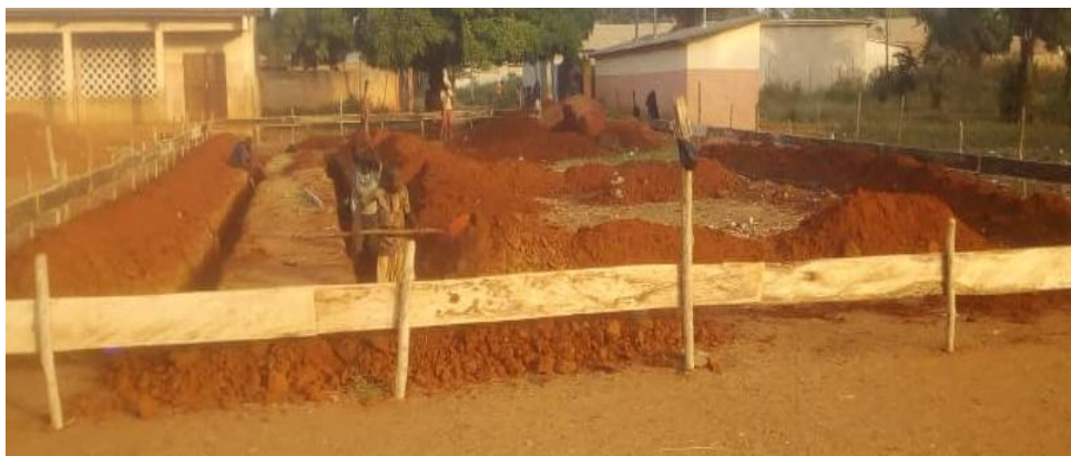
Photo 10 : Évolution des travaux de terrassement (source : MESSOUNA S.)
