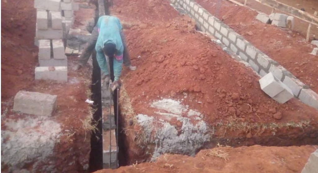
Photo 13 : Réalisation des murs de soubassement (source : MESSOUNA S.)
