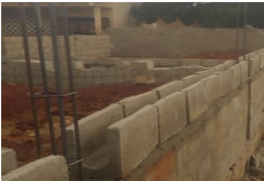
Photo 26 : Pose des agglo-coffrages pour chainages (source : MESSOUNA S.)
