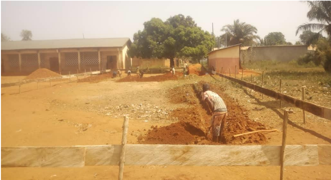
Photo 9 : Implantation du bâtiment et réalisation des fouilles (source : MESSOUNA S.)
