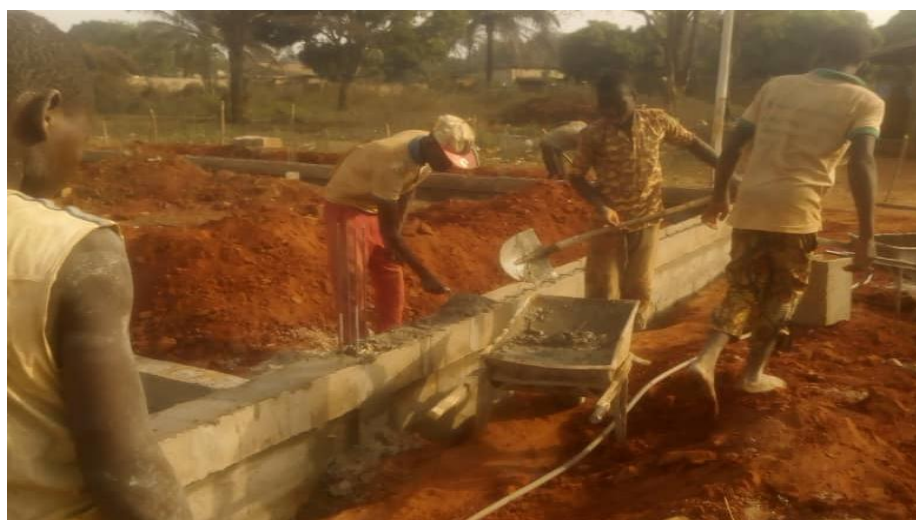
Photo 28 : Coulage des chainages (source : MESSOUNA S.)
