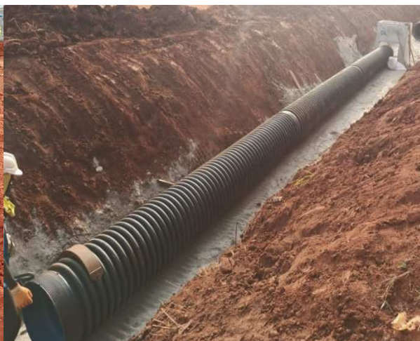
Photo N°11 : Pose de tuyaux PEHD Ø600 du réseau eaux pluviales sur la voie transversale.
