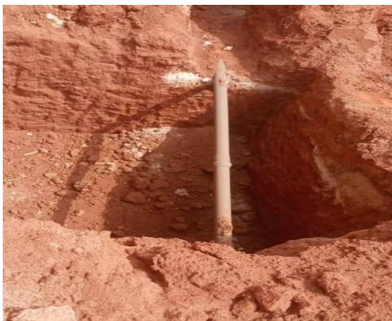
Photo N°5 : Conflit entre le réseau AEP et le réseau eaux usées sur la plateforme 4.4
