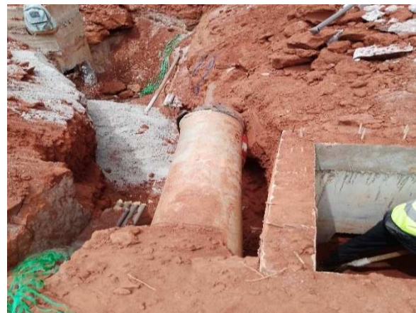
Photo N°9 : Tuyau PVC 200 utilisé pour protéger un tuyau AEP PVC 63 sur la voie transversale
