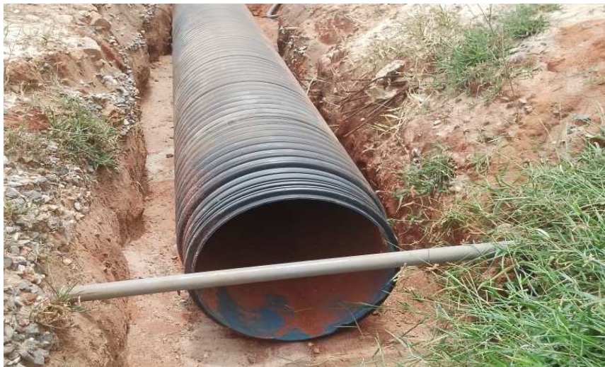
Photo N°7 : Conflit entre les réseaux eaux pluviales et AEP sur la voie secondaire 2
