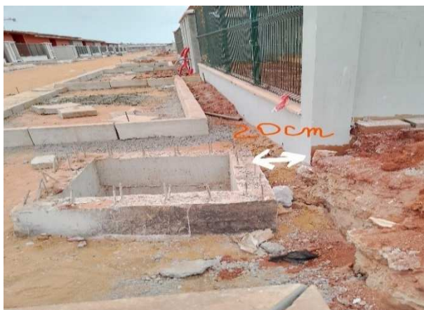
Photo N°8 : Espacement entre un regard eaux usées et la limite du bâtiment sur la rue N°2
