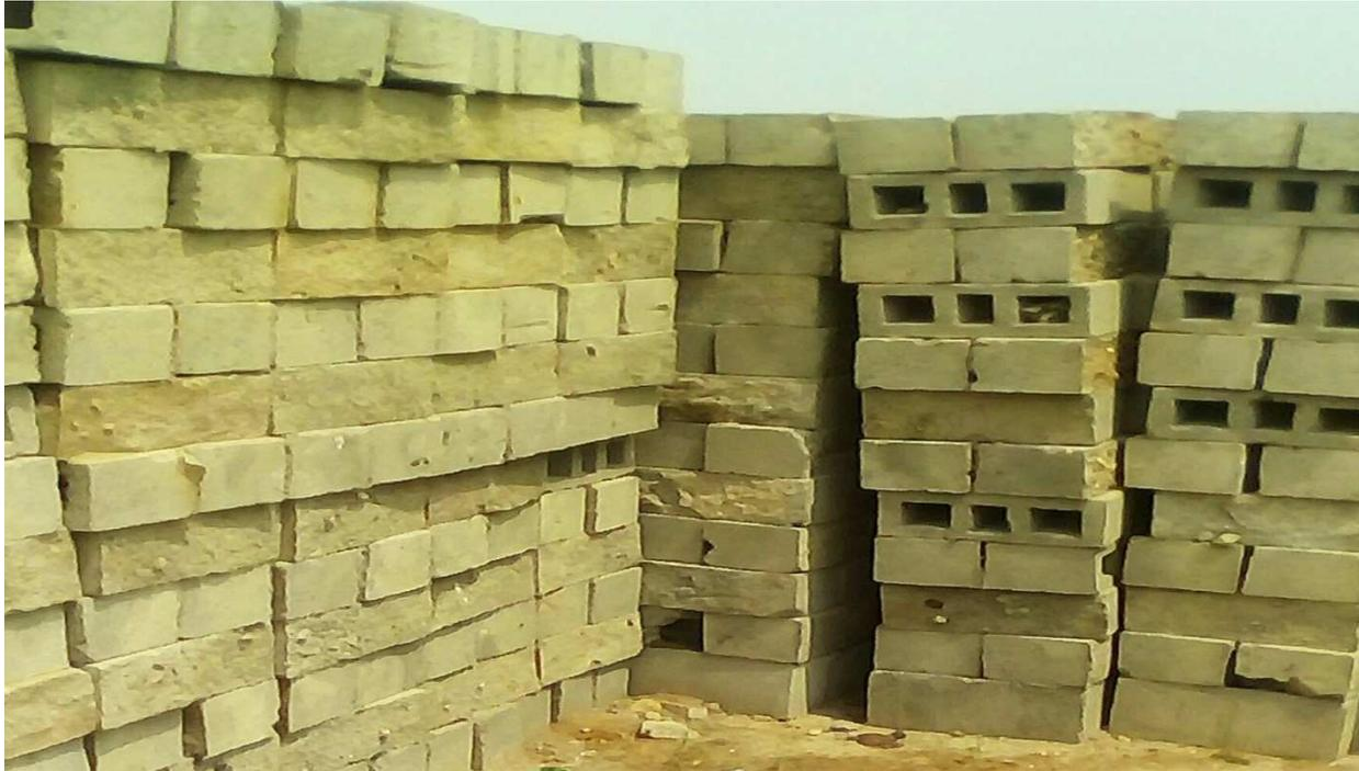
**Photo n° 16 montrant les agglos creuses de 15 sur l'aire de stockage**
