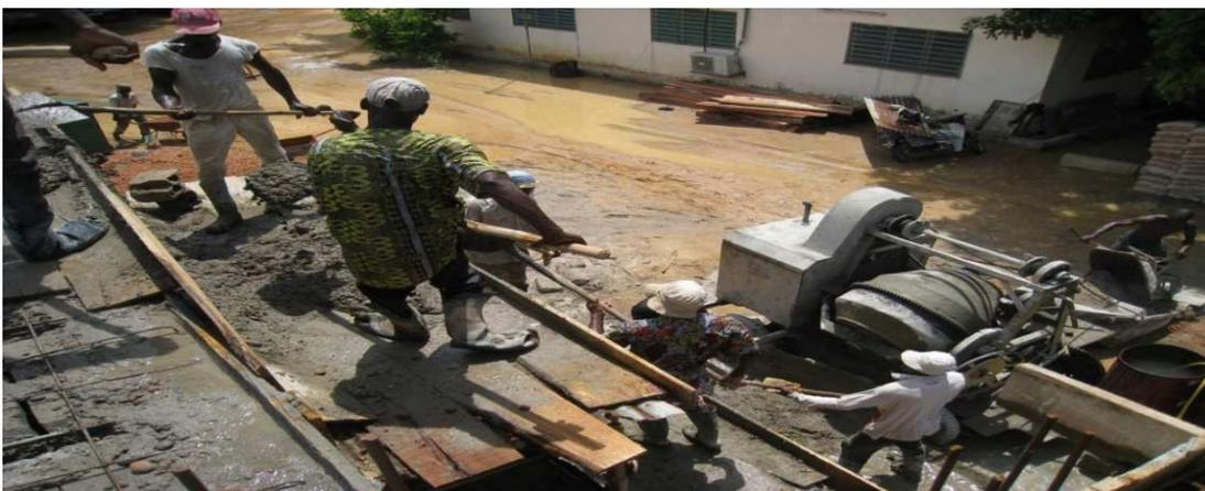
**Photo n°12 : Manutention du béton par échafaudage**
