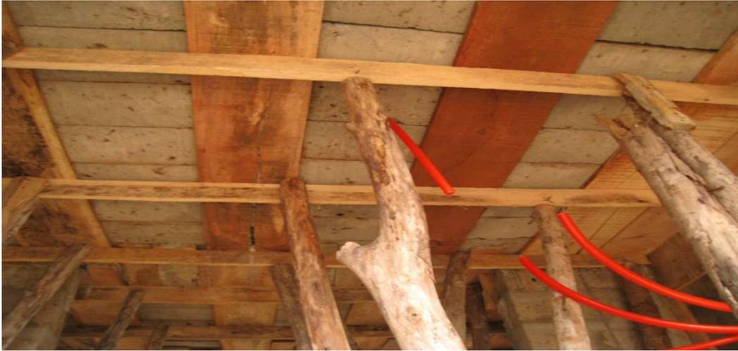
**Photo n°10 : Coffrage de dalle à poutrelles coulées sur place**
