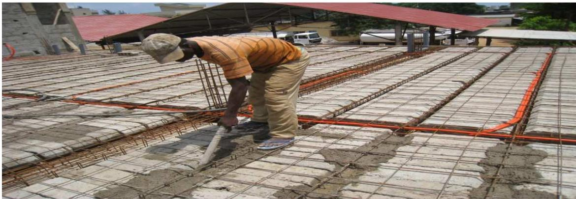
**Photo n°14 : Coulage de poutrelles sur place (fermeture des espaces supérieurs)**
