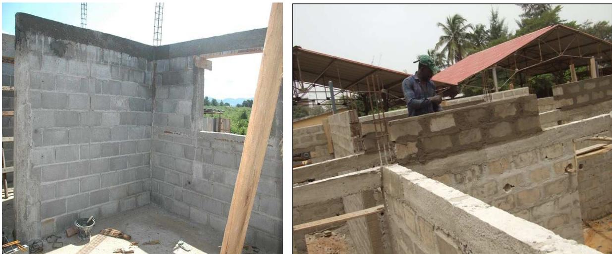
**Photos n°17 : Elévation de mur jusqu'au niveau chaînage linteau et de l'arase**
