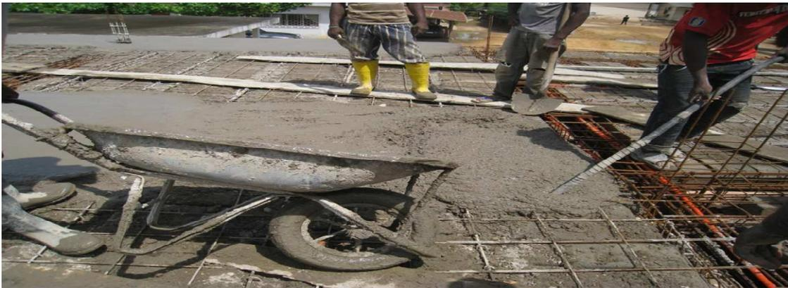
**Photos n°13 montrant le rapprochement du Béton lors du coulage de la dalle du RDC**
