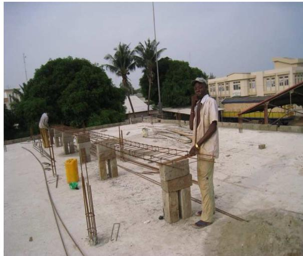
**Photo n°5 : Aire de stockage et de façonnage des aciers**
