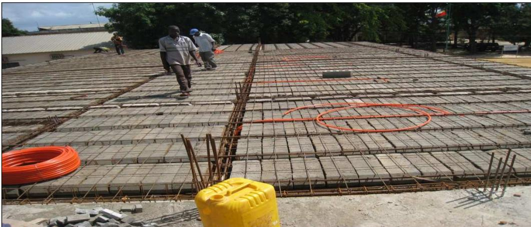
**Photo n°11 : Disposition des entrevous et armatures en cours**
