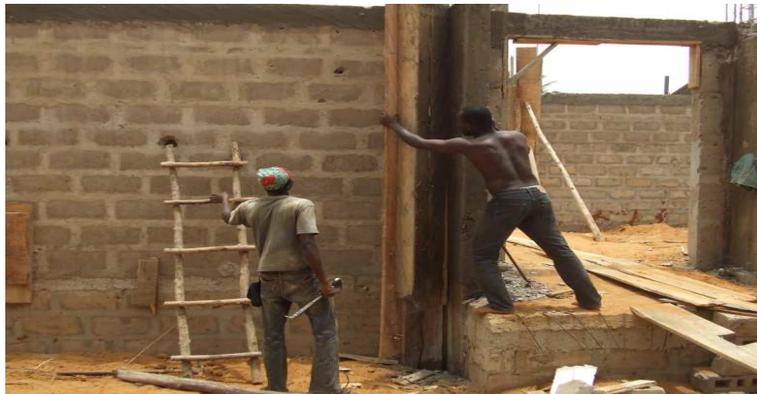
**Photo n°9 : Coffrage de poteaux en élévation**
