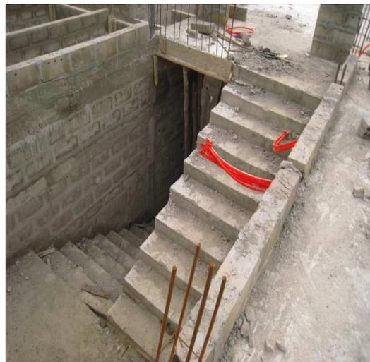
**Photos n° 15 montrant le coffrage et le décoffrage de l'escalier après coulage**
