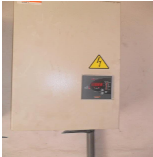
Figure III-2 : Coffret C2 de compensation de type standard
