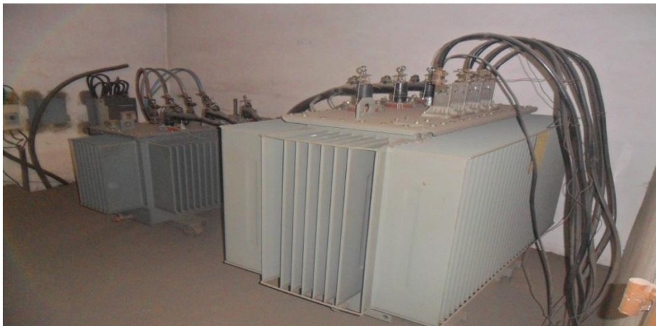
Figure III-1 : Les transformateurs de l'usine
