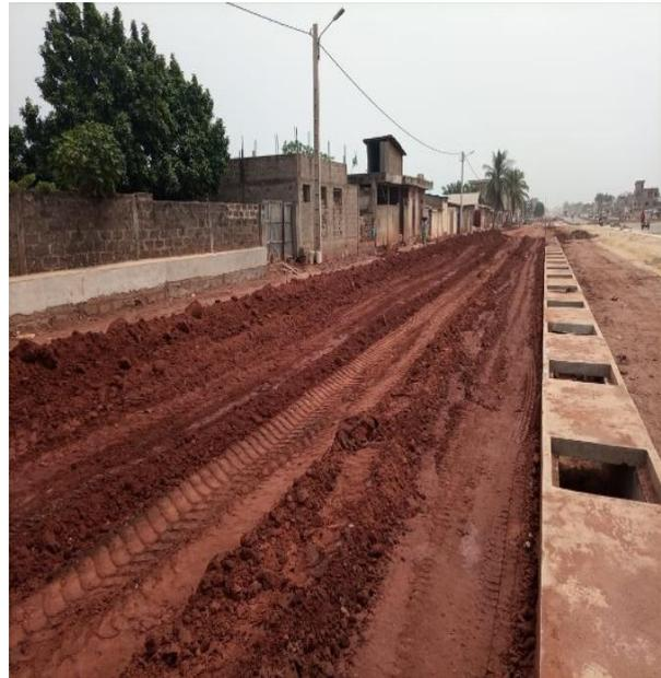
**Photo 2.2 :** Terre de barre retrouvée sur place, côte plateforme et mise en dépôt.
