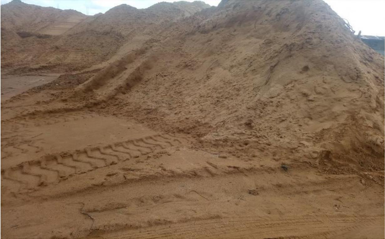
*Photo 2.1 : Silteux mis en dépôt.*
