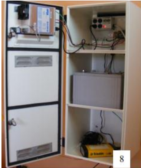
Figure 5: Un boîtier contenant une batterie et le récepteur NetR5 qui enregistre les données en continue et Cabine abritant le boîtier de la station permanente d'Abomey.
