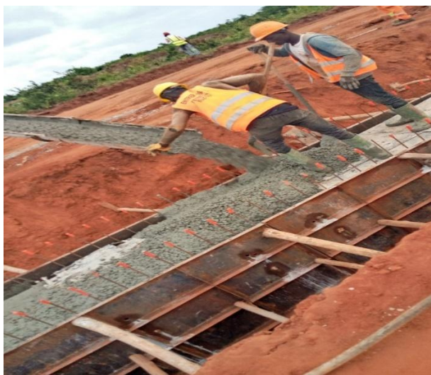
Photo 8: Vue montrant le coulage du tablier
