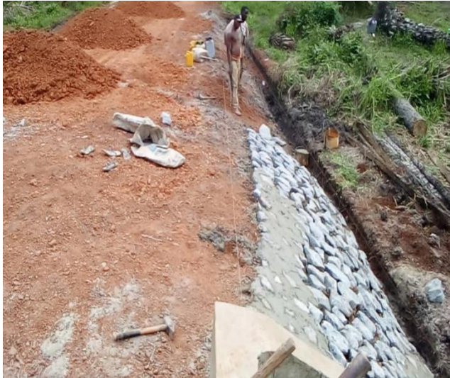
Photo 9: Vue montrant la réalisation du péré maçonné
