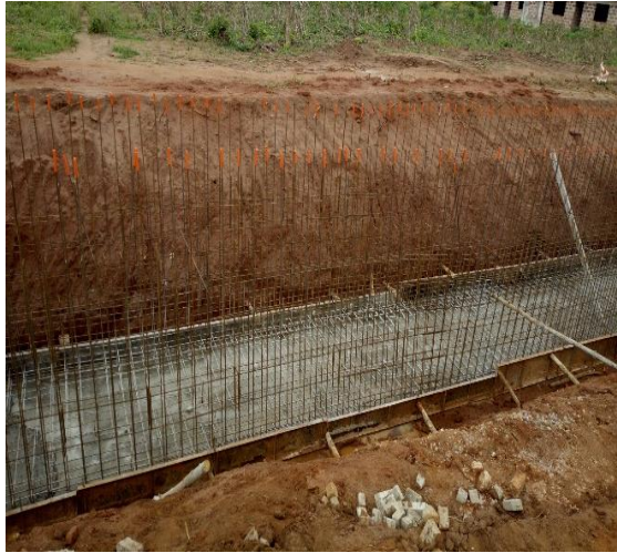
a-Ferrailage des voiles
