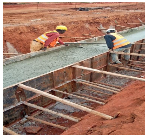
Photo 8: Vue montrant le coulage du tablier
