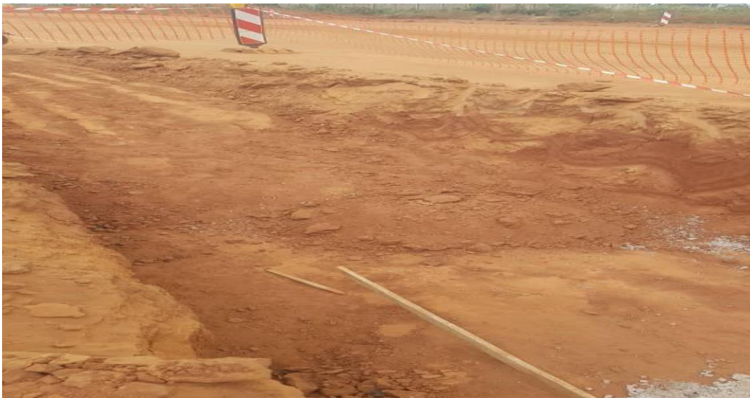
Photo 3: Vue montrant la réalisation de la fouille
