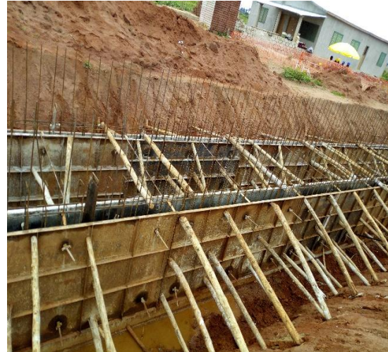
b- Coffrage et coulage des voiles
