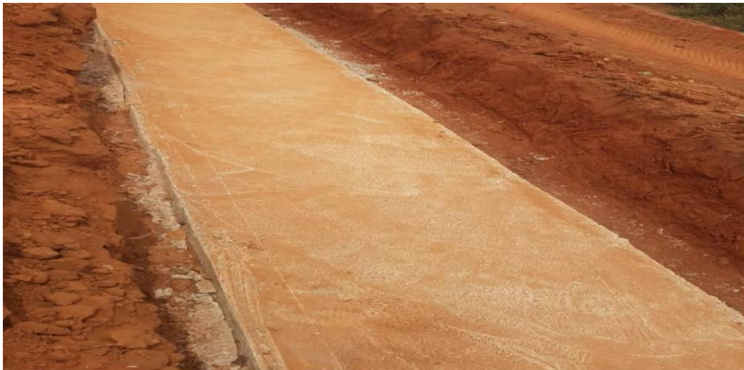
Photo 5: Vue montrant la pose du béton de propreté
