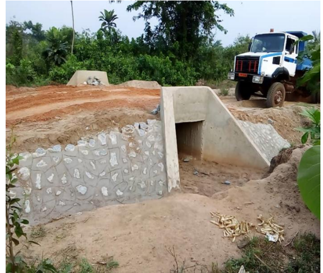
Photo 9: Vue montrant la réalisation du péré maçonné
