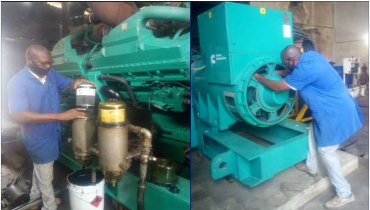
Figure 18 : Démontage et nettoyage de filtre à gasoil du groupe électrogène 2250 kVA
