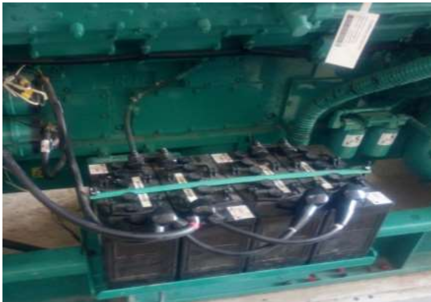
Figure 21 : Batteries du groupe de moteur 1250 kVA
