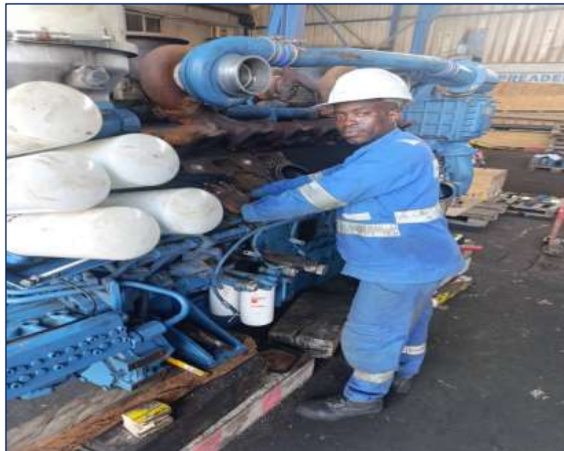
Figure 18 : Démontage et nettoyage de filtre à gasoil du groupe électrogène 2250 kVA
