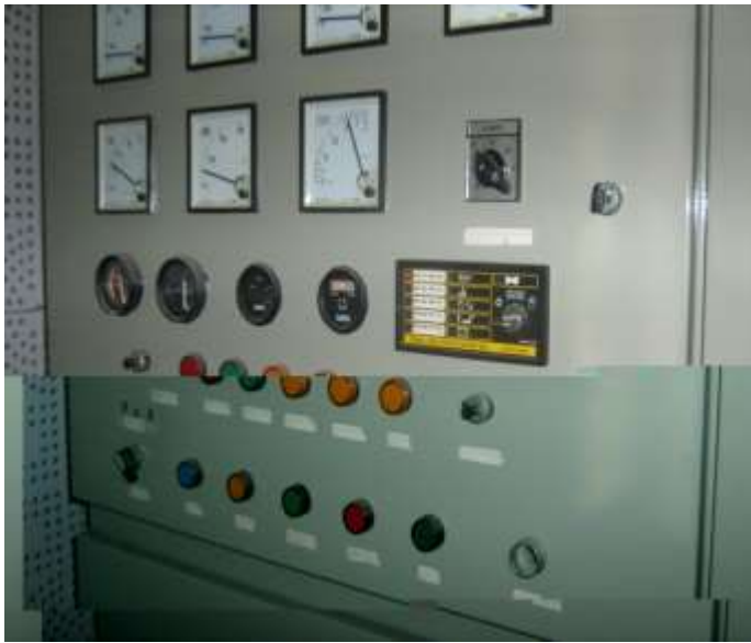
Figure 28 : Tableau de commande et de contrôle des grandeurs électriques
