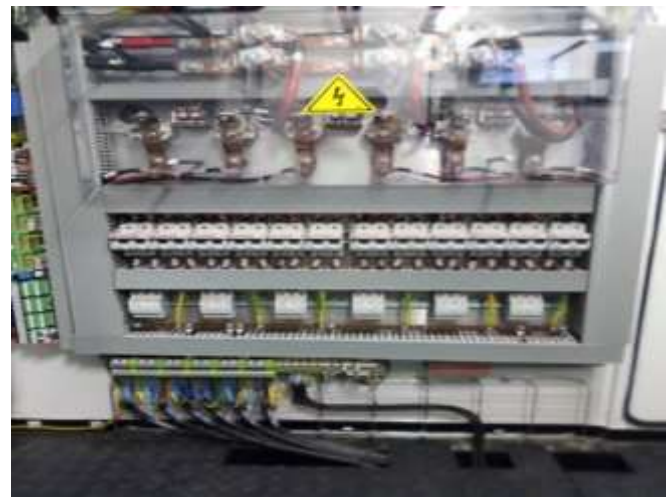
Figure 5 : Arrivée PV
