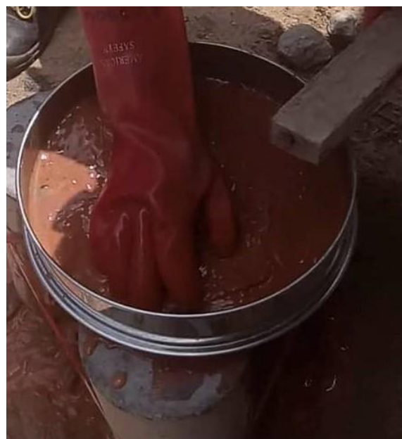
Lavage des granulats de tailles 0/4
