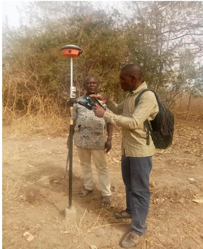
**Photo 3. 4 : Relevé de quelques bornes des titres fonciers à l'aide du récepteur GNSS-NAVCOM en présence des propriétaires.**
