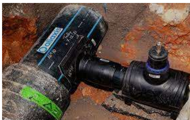
Photo 2 : Raccordement d'un nœud avec un Té sur du PEHD
