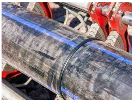
Planche 3 : Ensemble du PEHD par soudage
