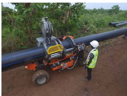
Planche 3 : Ensemble du PEHD par soudage
